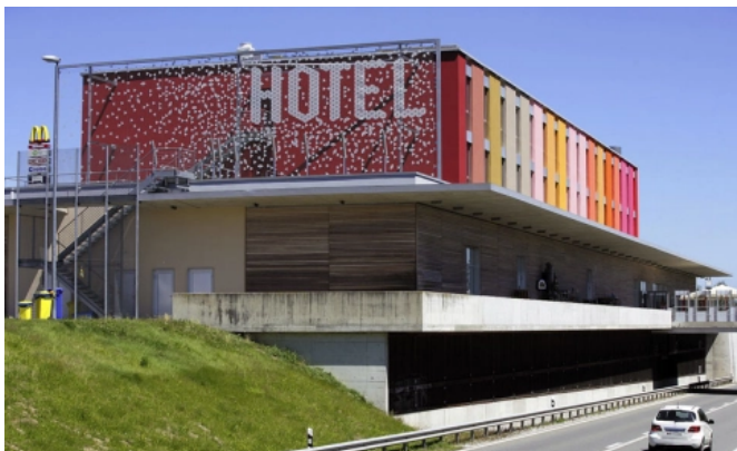
Vorgehängte Webnet-Fassade, Estavayer-le-Lac (CH)
