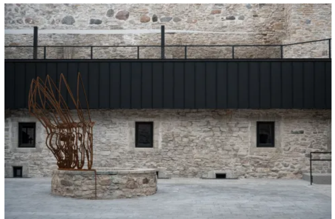
Mauerabdeckung (© Tönu Tunnel)
