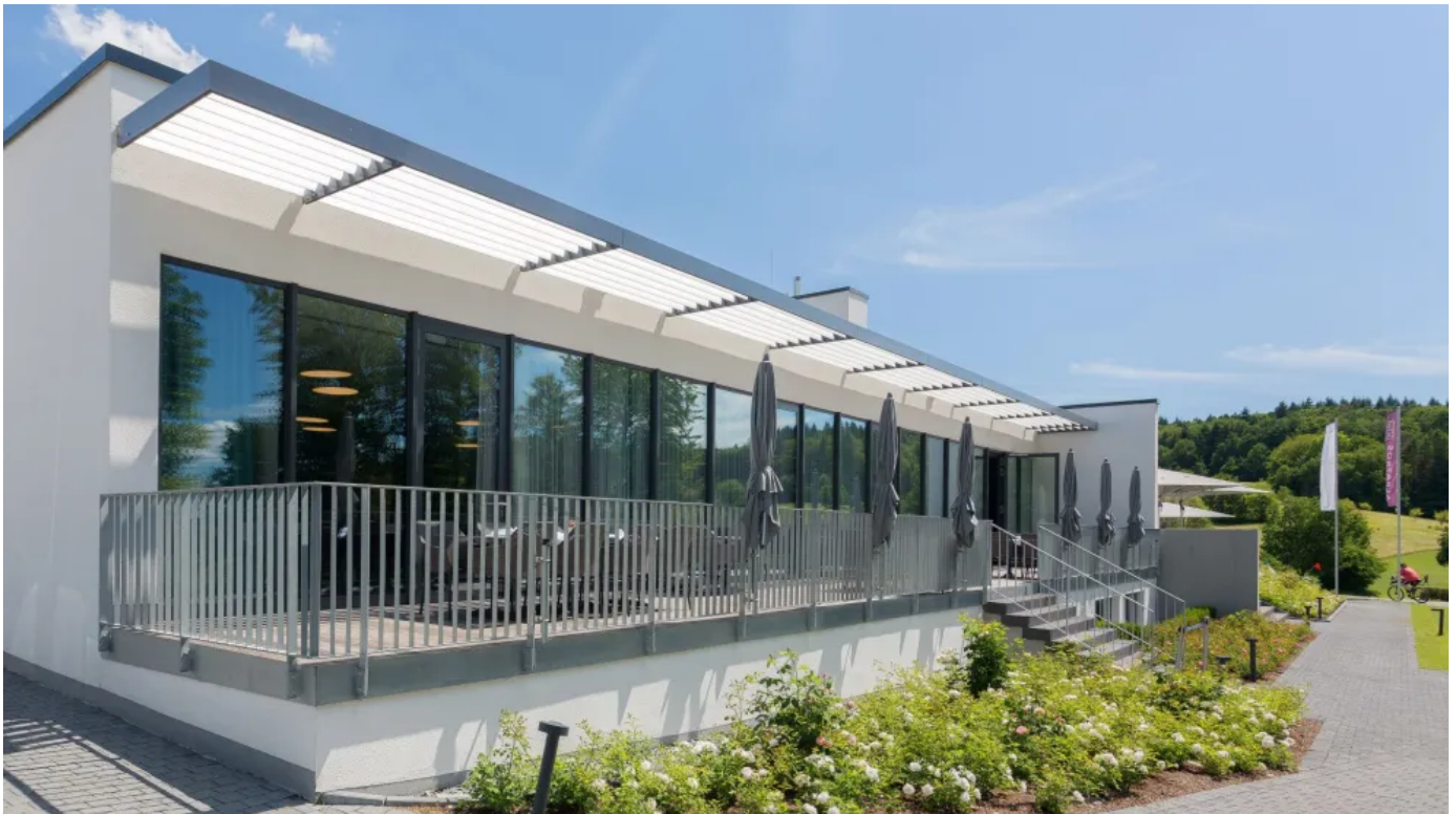
Auskragende Großlamellen-Sonnenschutzsysteme verhindern eine direkte Sonneneinstrahlung
