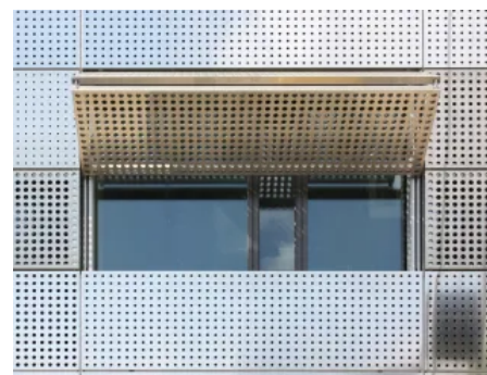
Ähnlich einem Vordach bietet der geöffnete Hebefaltladen Sonnenschutz
