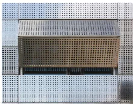
Die Fassade lässt sich auf Knopfdruck öffnen, der Sonnenschutz „faltet“ sich nach oben
