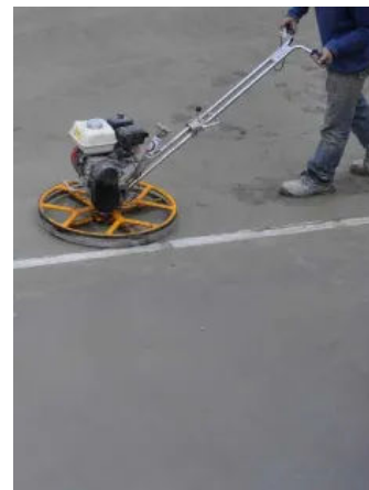
Flügelglätten des Betons bei eingebauter AquaStop Rinne.
