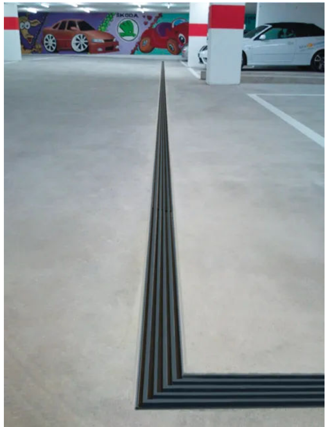
AquaStop Entwässerungsrinnen werden einfach in eine vorhandene Aussparung gesetzt oder mit einer Rinnenaufständerung direkt in Beton eingegossen.
