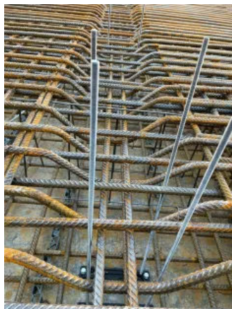
Bewehrung einbauen und Gewindestangen montieren.
