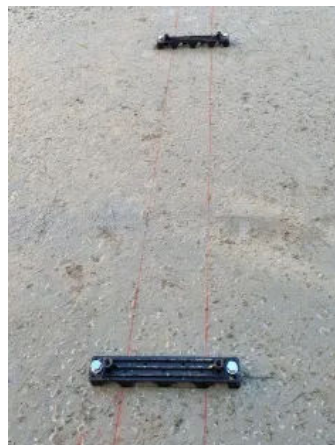
Kunststofffuß auf Sauberkeitsschicht aufschrauben.
