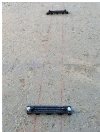
Kunststofffuß auf Sauberkeitsschicht aufschrauben.
