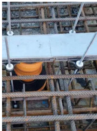
Rinne montieren und mit Montageabdeckblech schützen.
