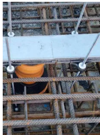
Rinne montieren und mit Montageabdeckblech schützen.
