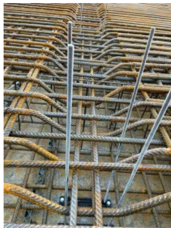
Bewehrung einbauen und Gewindestangen montieren.
