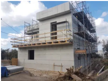
Aquafire als Untergrund für Wärmedämmverbundsysteme oder Außenwandbekleidung.
