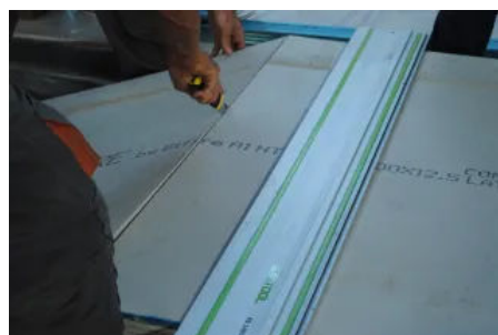
Die Bearbeitung der Aquafire-Bauplatten erfolgt im Ritz-/ Brechverfahren. Für den Zuschnitt können alle üblichen Werkzeugen für Zementbauplatten eingesetzt werden.
