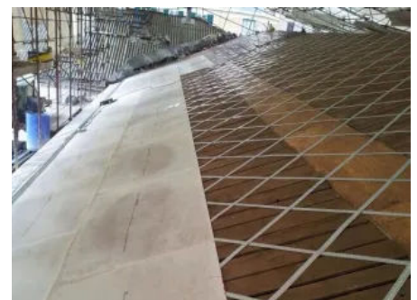
Feuchtebeständige Brandschutzbekleidung bei einer Holz-Zwischendecke mit Unterkonstruktion
