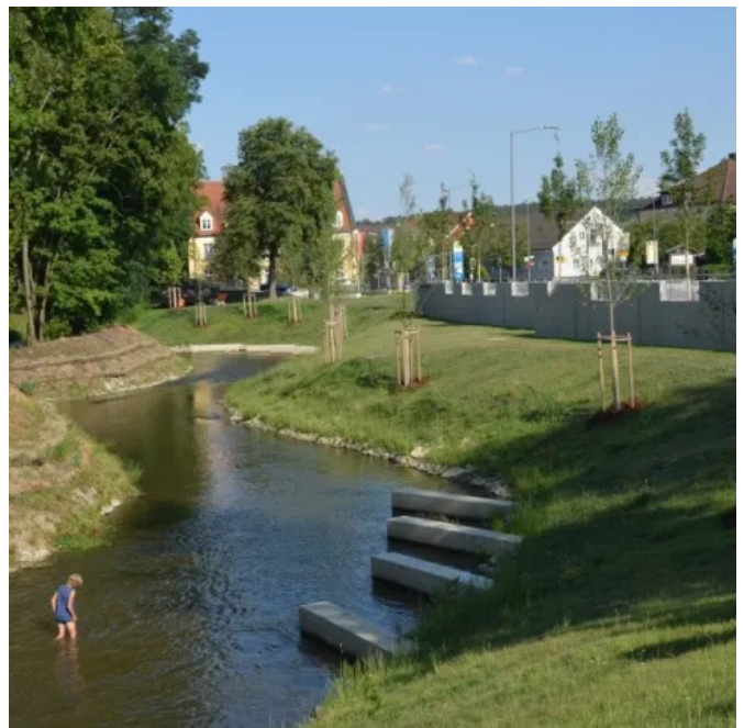
Dauerhafter Betonschutz mit HydroGraf® FL OS-A AGS Flüssig an den „Glonnterrassen“ in Allershausen
