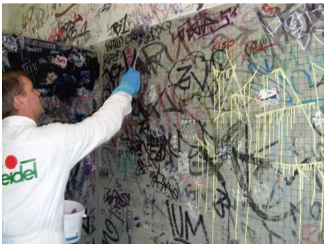
Auftragen des Graffiti-entferners mit der Farbwalze.
