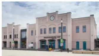
HydroPurSilan®, Bahnhof Brandenburg an der Havel
