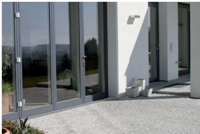
ANRIN Entwässerungsrinne im Innenhof
