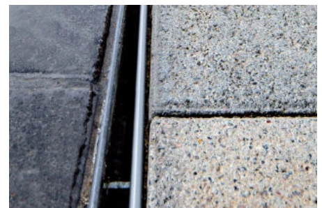
Einbaudetail im Pflasterbelag
