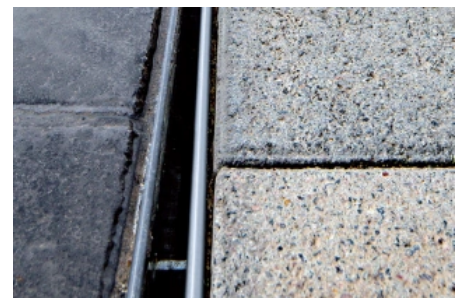
Einbaudetail im Pflasterbelag
