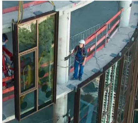
Elementfassade im Bau - Projekt: Innovationsbogen Augsburg (©Mediashots)
