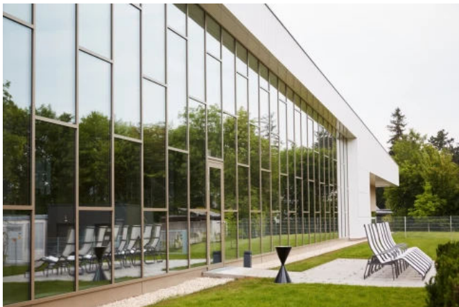
Pfosten-Riegel-Fassade - Projekt: Hallenbad Ried, WICTEC 50 (©Johannes Hloch)
