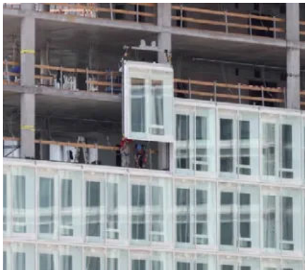
Elementfassade im Bau - Projekt: Henninger Turm, Frankfurt a. Main (©WICONA)
