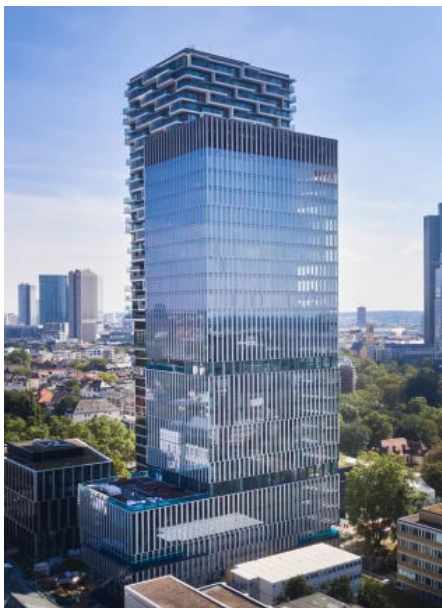
WICTEC EL EVO, Hydro CIRCAL - Projekt: Senckenbergturm, Frankfurt a. Main, (©Mediashots)
