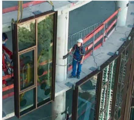
Elementfassade im Bau - Projekt: Innovationsbogen Augsburg (©Mediashots)
