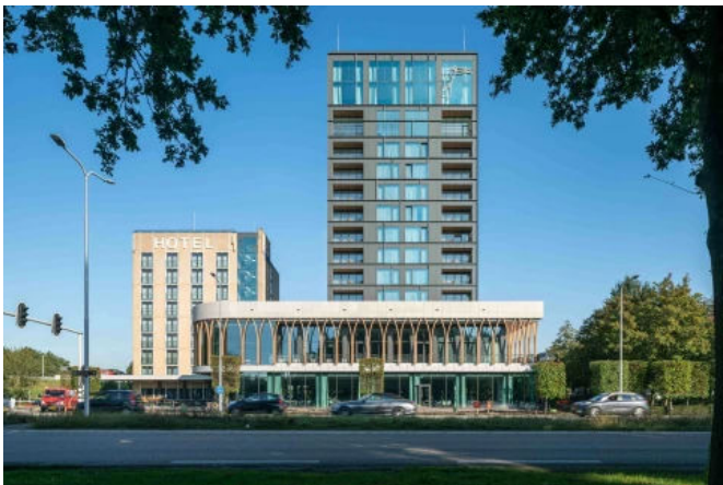
Sanierung - Projekt: Vandervalk Hotel, Venlo, Niederlande, WICTEC 50, Hydro CIRCAL (©Edbert de Boer)
