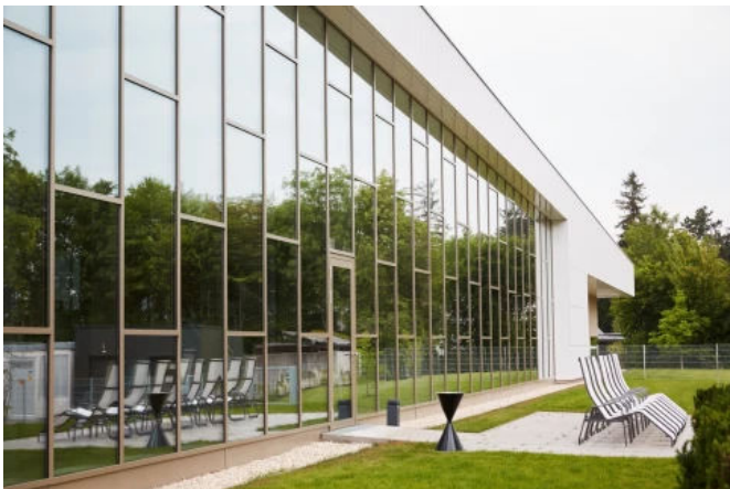
Pfosten-Riegel-Fassade - Projekt: Hallenbad Ried, WICTEC 50 (©Johannes Hloch)
