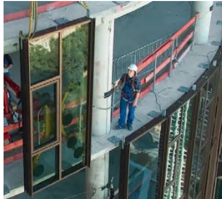
Elementfassade im Bau - Projekt: Innovationsbogen Augsburg (©Mediashots)
