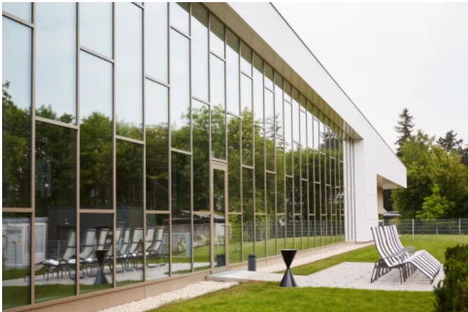
Pfosten-Riegel-Fassade - Projekt: Hallenbad Ried, WICTEC 50 (©Johannes Hloch)
