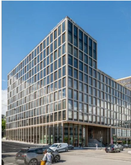
WICTEC Modul Air (Closed Cavity Fassade) - Projekt: Via Vika, Oslo, Norwegen (©Andrius Gudelis)
