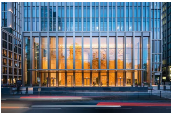
HUECK Trigon FS am Marienurm Frankfurt - LEED Platin Zertifizierung(U.S. Green Building Council)
