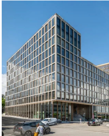
WICTEC Modul Air (Closed Cavity Fassade) - Projekt: Via Vika, Oslo, Norwegen (©Andrius Gudelis)
