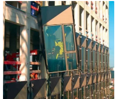
Elementfassade im Bau - Projekt: Nationalbibliothek Leipzig (©Conné van d'Grachten)
