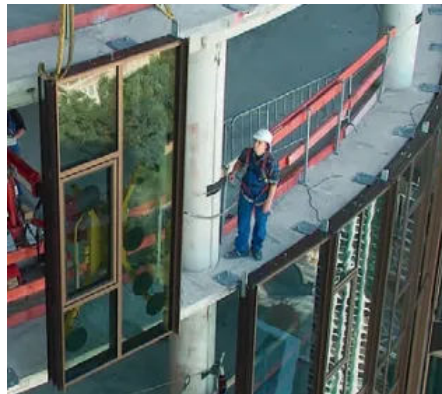
Elementfassade im Bau - Projekt: Innovationsbogen Augsburg (©Mediashots)
