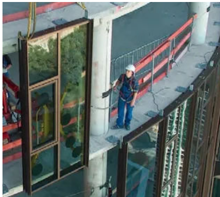
Elementfassade im Bau - Projekt: Innovationsbogen Augsburg (©Mediashots)
