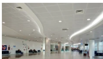
Metalldecken mit verdeckter Unterkonstruktion Armstrong METAL Board, Tegular (© Filippo di Pretoro)
