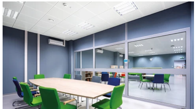
Metalldecken mit sichtbarer Unterkonstruktion (© Szymon Polański)
