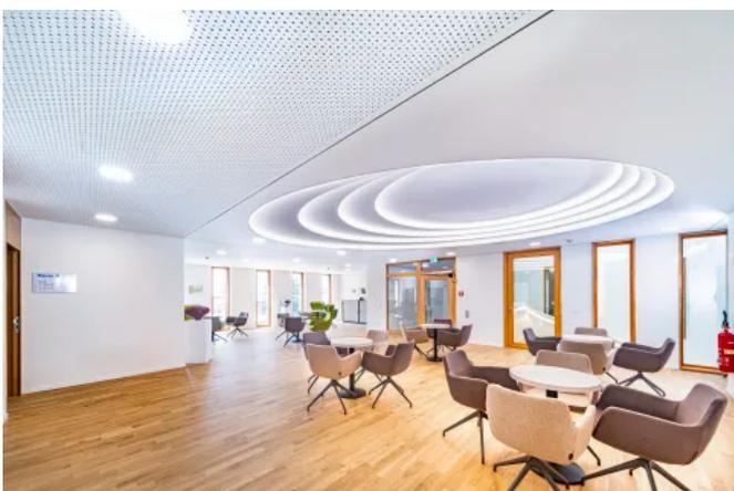
Schallabsorbierende Decken mit Knauf Cleaneo Lochplatten verkürzen die Nachhallzeit im Raum.
