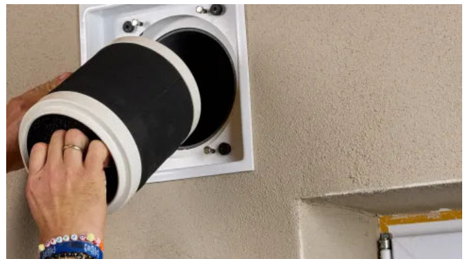
Das Aireco® Lüftungssystem beinhaltet ein Lüftungsgerät 60 m³/h mit Wärmerückgewinnung.
