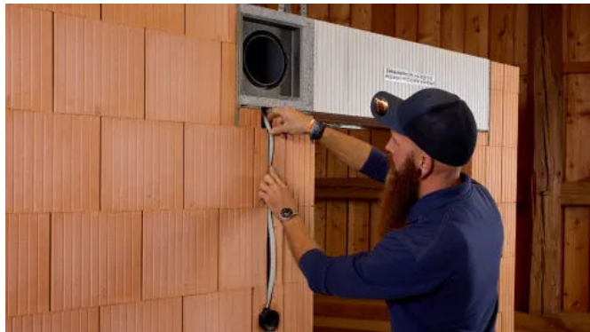
Die dezentrale Lüftung Aireco® mit Wärmerückgewinnung ist energieeffizient und an der Fassade unsichtbar.
