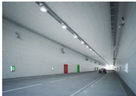
Nachträglich montierte Brandschutzbekleidungen
