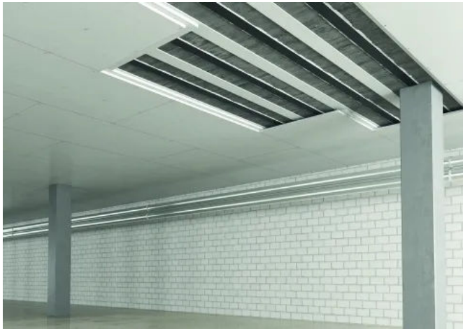
Bekleidung von Klebarmierungen F30 – F90 (CFK Lamellen)
