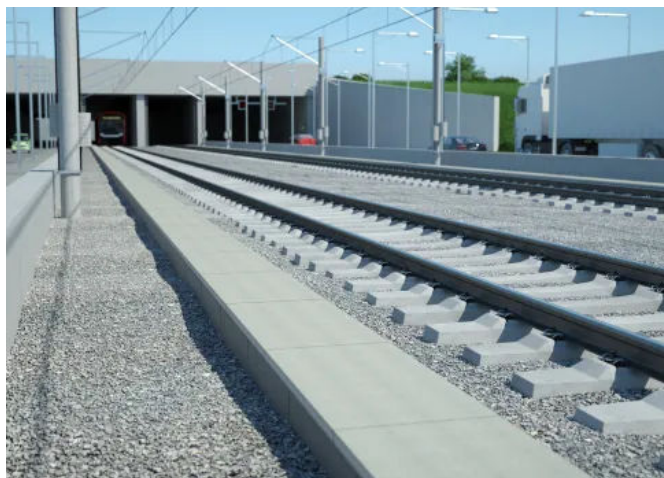
Abdeckung von Flucht- und Rettungswegen
