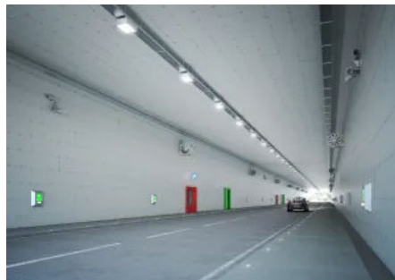
Nachträglich montierte Brandschutzbekleidungen
