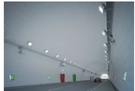
Nachträglich montierte Brandschutzbekleidungen für Tübbingelemente
