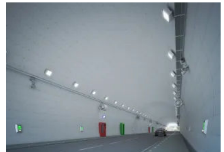
Nachträglich montierte Brandschutzbekleidungen für Tübbingelemente
