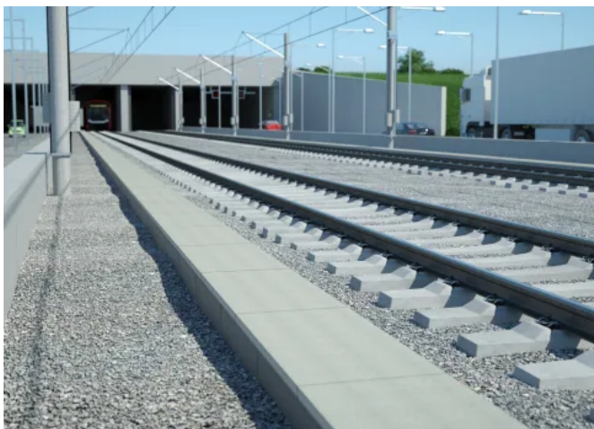
Abdeckung von Flucht- und Rettungswegen
