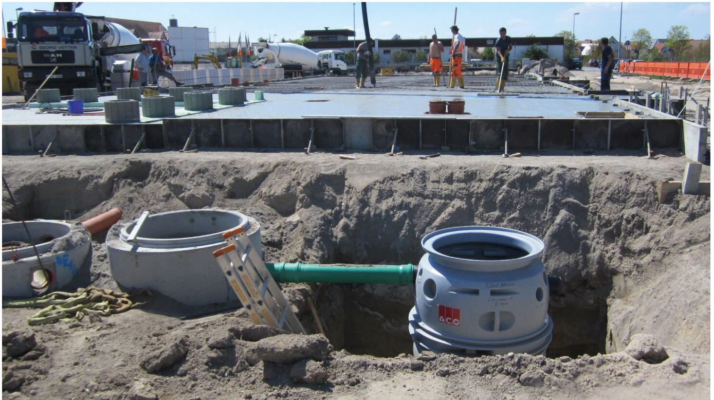
Fettabscheider aus Stahlbeton und PE-HD für den Erdeinbau
