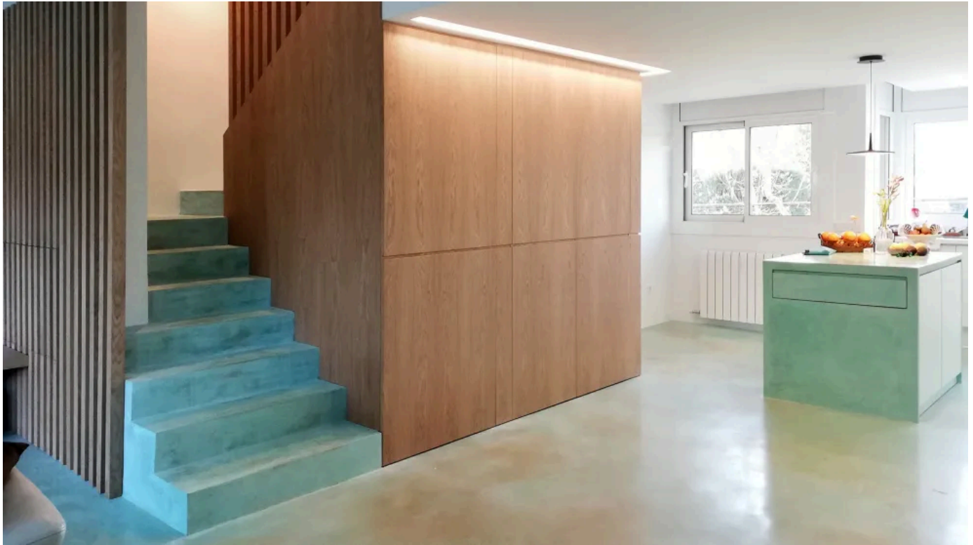
Auch Treppen lassen sich mit Acid-Stain-Dekorboden realisieren.
