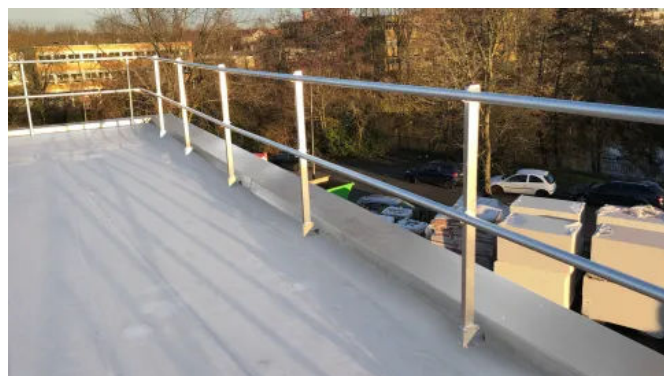
Einbaubeispiel LUX-top® G-T DIREKT AT für Direktbefestigung
