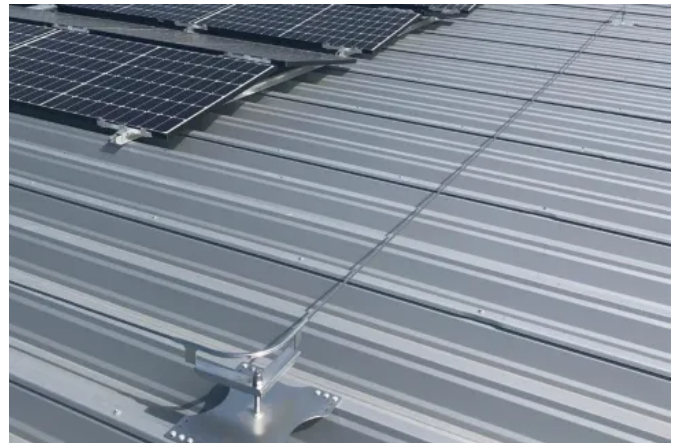
Das Seilsicherungssystem ist mit Anschlagpunkten für verschiedene Untergründe - auch in überfahrbarer Ausführung - lieferbar.
