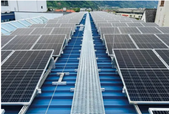
LUX-top® FSE 2003 Seilsystem bietet Arbeitssicherheit für bis zu 6 Personen gleichzeitig, z.B. bei Schneerräumung der PV-Anlage.
