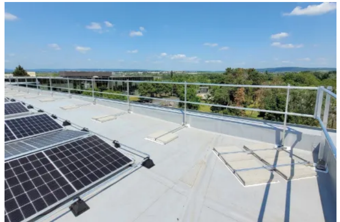
Die auflastgehaltene LUX-top® G-T Seitenschutzsysteme werden durchdringungsfrei mit Ballastbeschwerung montiert.
