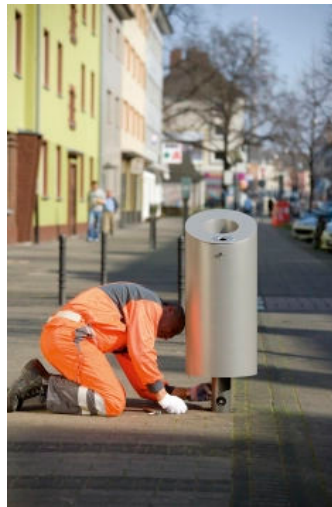
2. Spannkegel entnehmen
