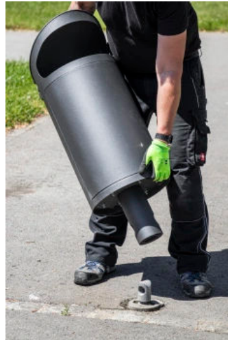
Abfallbehälter auf der Verbindungsstück aufsetzen
