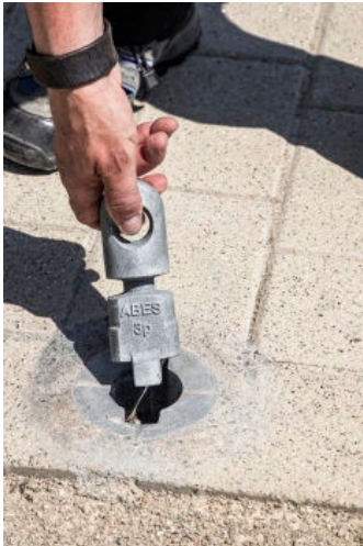
Verbindungsstück in die Bodenhülse einsetzen
