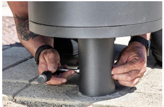
Spannkegelsatz einsetzen festschrauben
