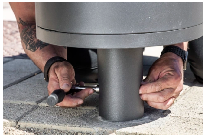
Spannkegelsatz einsetzen festschrauben
