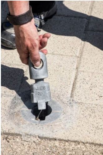
Verbindungsstück in die Bodenhülse einsetzen
