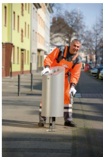
5. Verbindungsstück einsetzen
