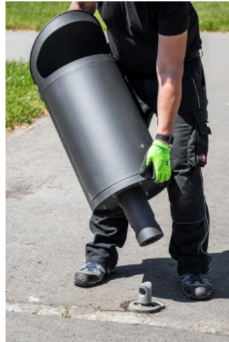
Abfallbehälter auf der Verbindungsstück aufsetzen
