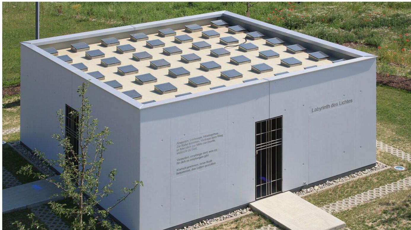
Mit Triflex-Flüssigkunststoffen werden komplexe Dachlandschaften zuverlässig abgedichtet. Die mehrkomponentigen Materialien werden mit Pinsel oder Rolle frisch in frisch flüssig aufgetragen. Sie härten durch chemische Vernetzungsreaktion aus.
