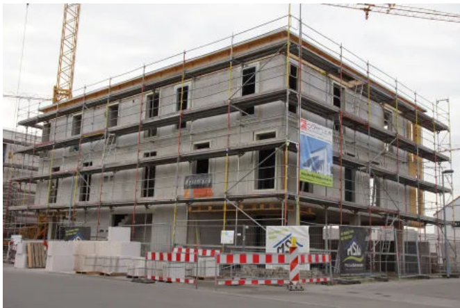
In den „New WALLDORF LOFTS“ wurde ISO-TOP WINFRAMER „TYP 1“ eingesetzt.
