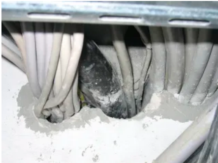
Fehlerhafte Kabelabschottung erhöht das Risiko im Brandfall
