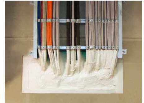
Korrekte Brandabschottung mit ISO-FLAME PLATTEN S 90
