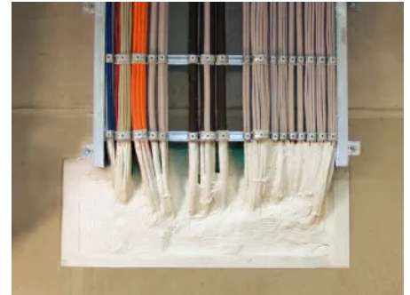
Korrekte Brandabschottung mit ISO-FLAME PLATTEN S 90
