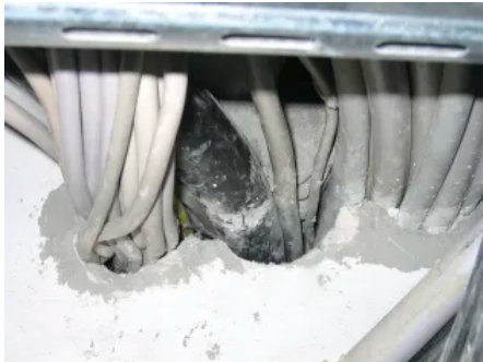
Fehlerhafte Kabelabschottung erhöht das Risiko im Brandfall
