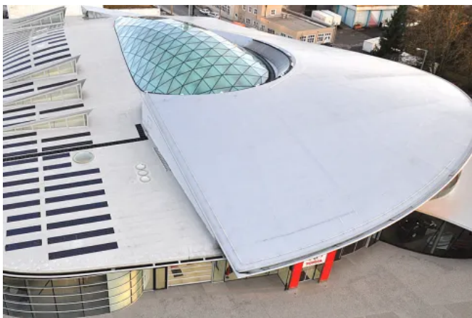
Mit ihrer hellgrauen Oberfläche reflektiert NovoProof® DA-G das Sonnenlicht und trägt zum Hitzeschutz bei.
