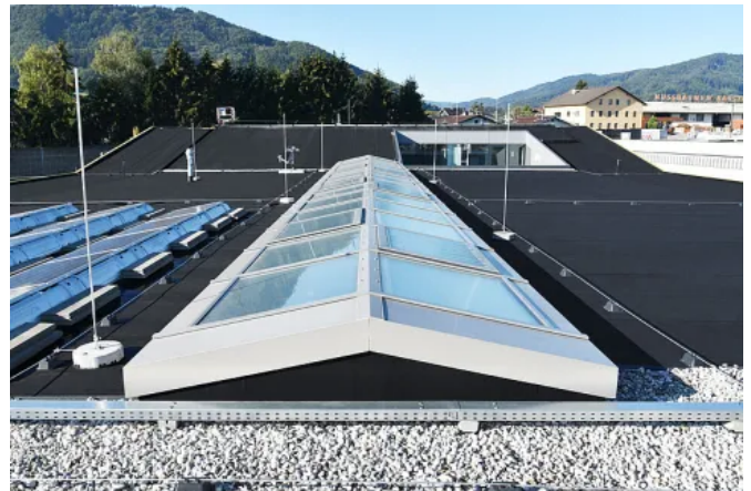
Bei Dächern mit vielen Anschlussstellen ist die COVERiT NovoProof® Großflächenabdichtung besonders wirtschaftlich.
