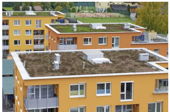
NovoProof® DA-G und DA-K Bahnen können für Gründächer ohne separate Wurzelschutzbahn eingesetzt werden.
