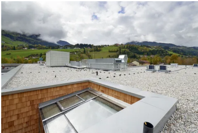
NovoProof® DA-P dient fertige Abdichtungseinheit für die lose Verlegung mit Auflast.
