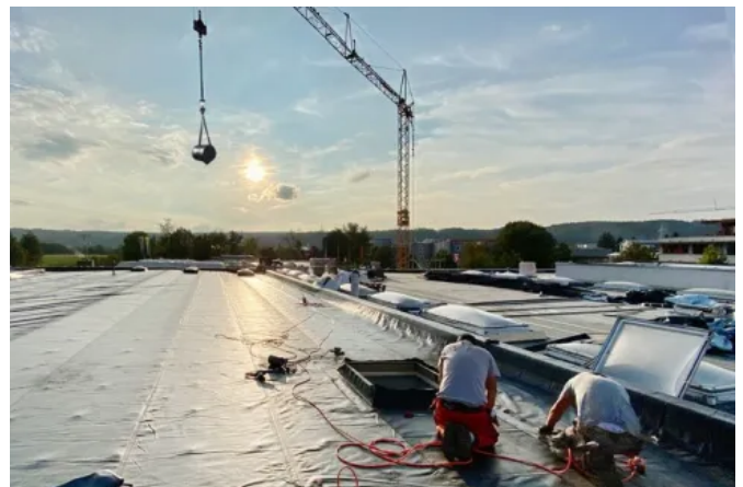
Durch die Vorfertigung im Werk reduzierten sich Aufwand und Fehlerquellen auf der Baustelle.
