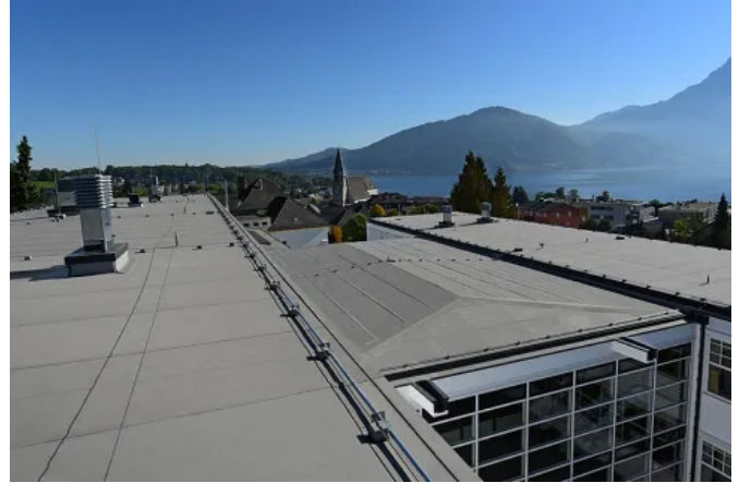
COVERiT NovoProof® DA-FG kann direkt auf der EPS Dämmung verlegt werden - ohne zusätzliche Brandschutzlage.
