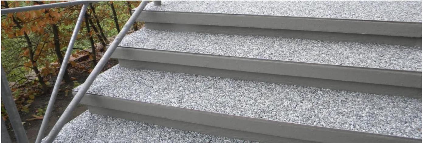
Treppen-Beschichtungssystem: Triflex TSS ist eine speziell für Treppen entwickelte Dickbeschichtung. Der Verlaufmörtel hält den hohen mechanischen Belastungen auf Treppen dauerhaft stand.
