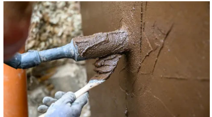
Rohr- oder Kabeldurchführung, im Nachgang mit Sopro KMB Flex-2-K Poly überarbeitet (© Christoph Mertens)
