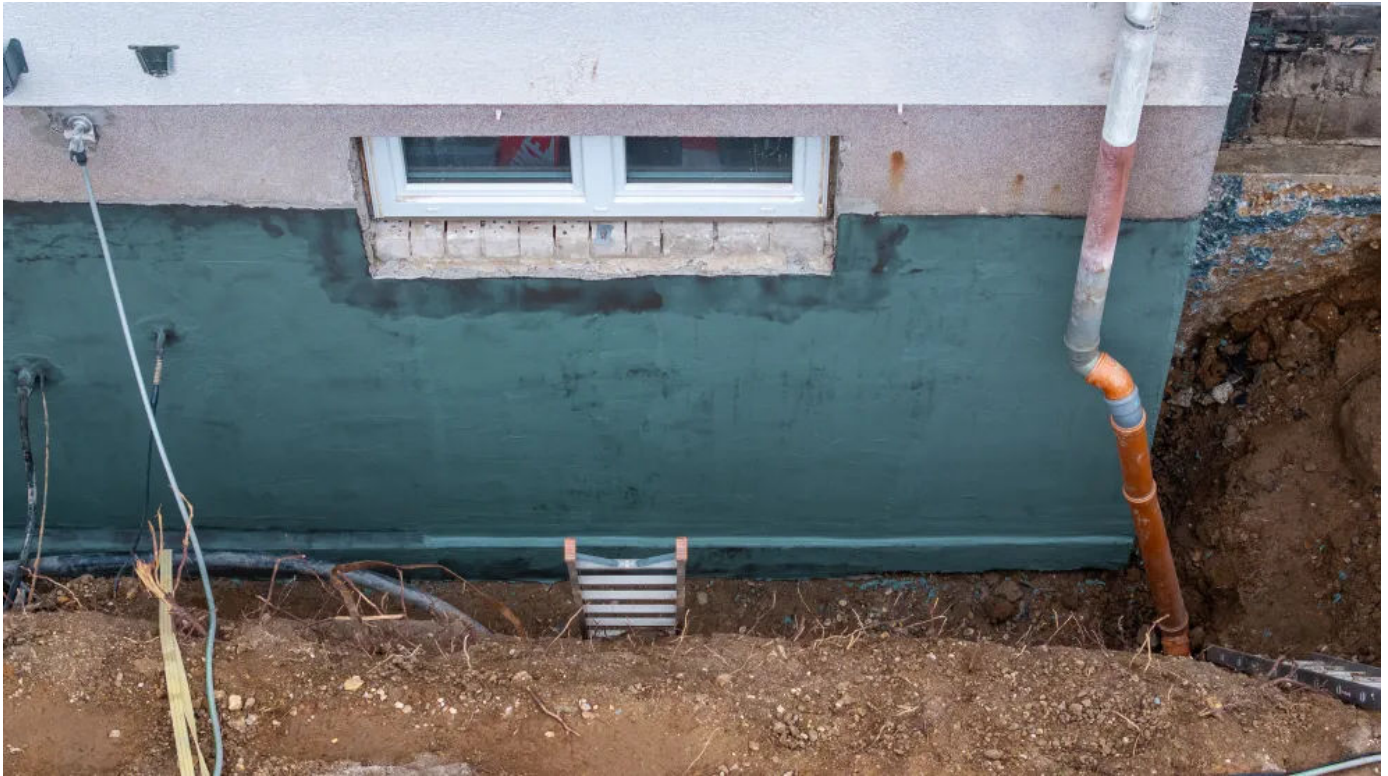
Überarbeitete Altabdichtung mit FPD (© Christoph Mertens)
