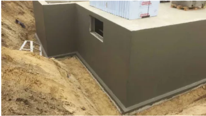
Bauwerksabdichtung mit FPD
