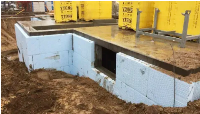
Kelleraußenwand mit Flächenabdichtung und Perimeterdämmung
