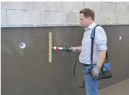
Die Abdichtungsschicht wird mit einem elektrischen Streustrom-besen abgefahren.
