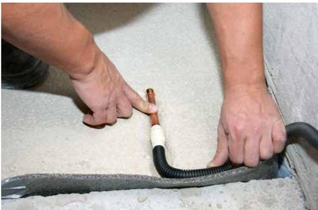
**3** Den Temperaturfühler in das Leerrohr einschieben und das Kabel zur Schalterdose führen.
