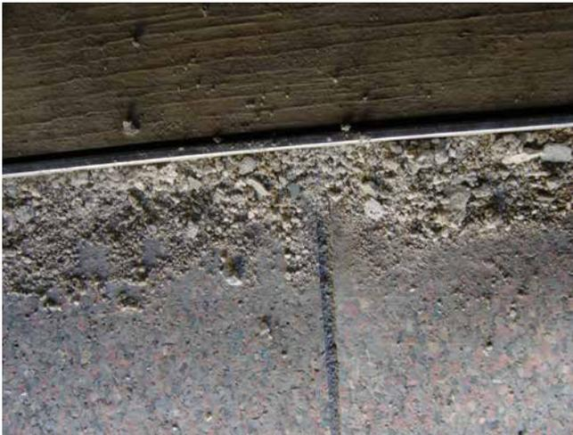
Kontakt aufgrund klaffender Fuge zwischen zwei Dämmplatten, welche mit Mörtel gefüllt ist.
