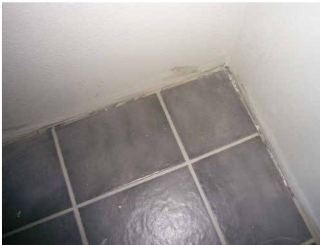
Wandkontakt des Klebers/Mörtels aufgrund fehlender Randdämmstreifen.
