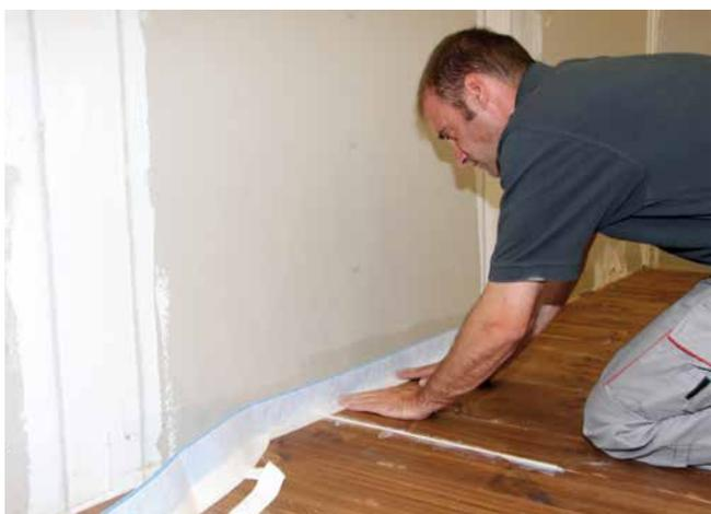
5 Zu allen aufgehenden Bauteilen (Wände) sind Randdämmstreifen (z. B. Sopro RandDämmStreifen) zu stellen.
