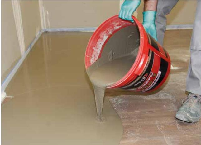
**7** Der flexible, faserverstärkte, selbstverlaufende Sopro FaserFließSpachtel wird im direkten Kontakt zum Holzdielenboden aufgebracht.
