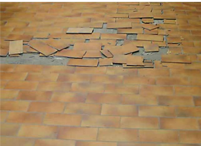
Haftverbundschaden aufgrund zu früher Belegung der Betonbodenplatte.
