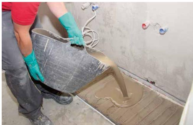
**6** Die Heizmatte wird in gleichmäßiger Schichtdicke flächig mit Sopro Fließspachtelmasse oder Sopro Dünnbettmörtel eingebettet. Nach Erhärtung des Mörtelbettes kann der Belag mit flexiblem Sopro Dünnbettmörtel verlegt werden.
