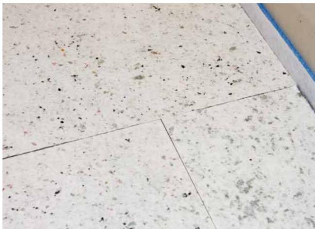
**13** Die Verlegung erfolgt stoßversetzt.
