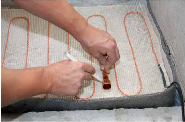
**1** Verlegeplan durch Ausrollen der Heizmatte auf Untergrund erstellen, um gewünschte Position des Heizfühlers zu ermitteln. Falls erforderlich, Trägergewebe einschneiden und Heizmatte(n) anpassen. Achtung: der Heizfühler darf nicht direkt unter dem Heizleiter liegen!
