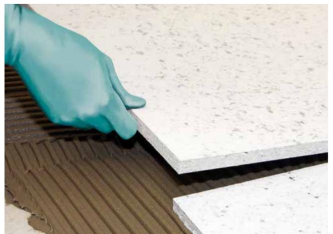
**12** Die Sopro FliesenDämmplatten lassen sich leicht verlegen, da sie nur direkt aneinander gestoßen werden.
