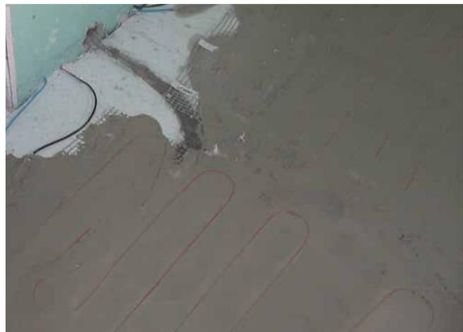
Elektro-Fußbodenheizung eingebettet in Sopro's No. 1 S1 Flexkleber.
