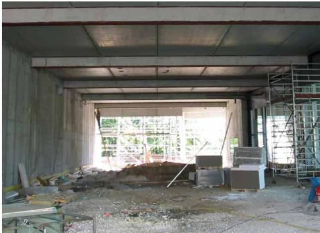
Überhöhte, vorgespannte Deckenkonstruktion, welche sich entspannt und sich im Mittelpunkt 2–4 cm absenken kann.
