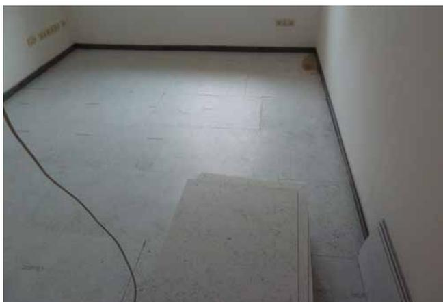
**3** Damit aus der Unterkonstruktion keine Spannungen und Verformungen auf den folgenden beheizten Aufbau übertragen werden, ist diese mit der Sopro FliesenDämmplatte 4 bzw. 7 mm zu entkoppeln. Die Sopro FliesenDämmplatte ist mit einem Fliesenkleber (z. B. Sopro's No. 1 schnell) zu verkleben.
