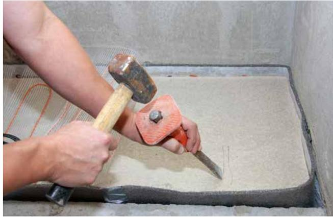
**2** Untergrund an gewünschter Stelle für Fühlerhülse aufstemmen. Hinweis: Die Effektivität der Heizleistung kann durch das Verlegen der Sopro FliesenDämmPlatten optimiert werden. Die Abgabe der Heizwärme in den Estrichuntergrund wird so reduziert.
