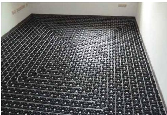
**4** Auf der entkoppelten Fläche ist das Kermi x-net C15 Dünnschichtsystem im direkten Kontakt zu verlegen und zu installieren.
