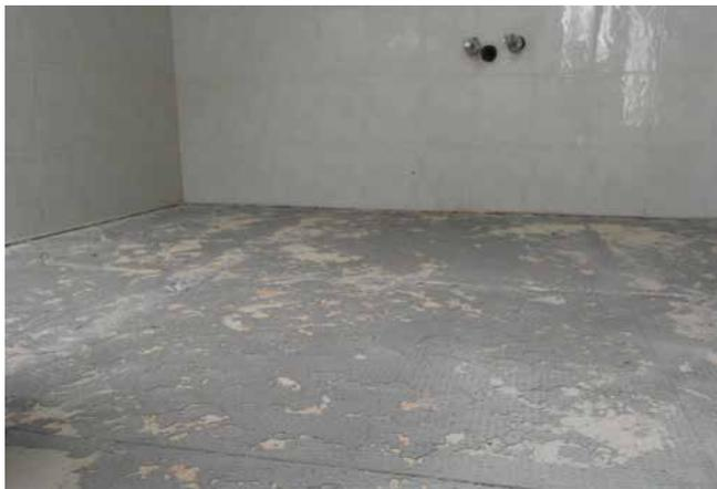
**1** Nach dem Rückbau des Altbelags kommt die kritische Holzkonstruktion zum Vorschein. Die Holzoberfläche und ggf. Kleberreste sind mit Sopro HaftPrimer S zu überarbeiten.
