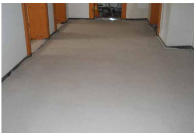
**6** Nach dem Aushärten der Fließspachtelmasse (am nächsten Tag) kann unmittelbar mit der Fliesenverlegung begonnen werden.
