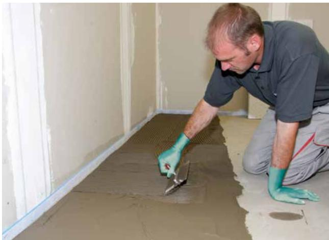
**9** Ist der Holzuntergrund planeben, wird z.B. Sopro VarioFlex® XL direkt auf die mit Sopro HaftPrimer S vorbereitete Fläche für die Verlegung der Sopro FliesenDämmplatte aufgekämmt.
