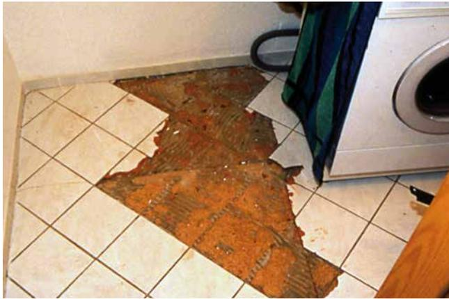
Rissbildung im Oberbelag im Bereich der Spanplattenstöße, verursacht durch Schwingung (z. B. Waschmaschine).
