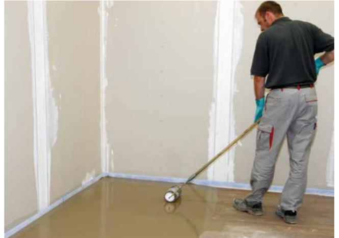
**8** Mit einer Stachelwalze wird der Sopro FaserFließSpachtel verteilt und verdichtet, um abschließend eine planebene Oberfläche zu erhalten.
