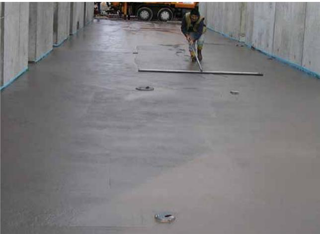
Frische Betonbodenplatte in einem Flughafenterminal.
