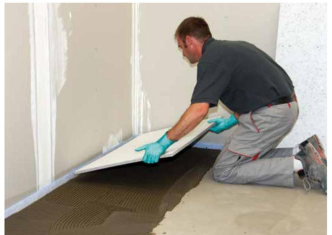
**10** Die Verlegung der Sopro FliesenDämmplatte (9 mm) erfolgt vollsatt in das vorgezogene Mörtelbett.
