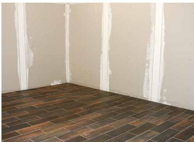
**18** Entkoppelter keramischer Belag auf einem Holzuntergrund.
