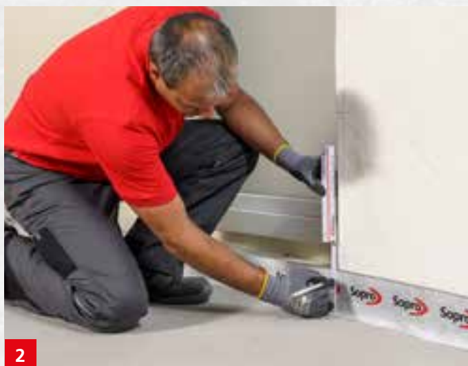
2 Anzeichnen des Meterrisses und der Orientierungspunkte. Zu berücksichtigen sind die erforderlichen Einbauhöhen: Sopro SMART® Leichtausgleich (> 20 mm im Verbund), Sopro VarioFließspachtel (> 10 mm), Kleberschicht und Stärke der Keramik.
