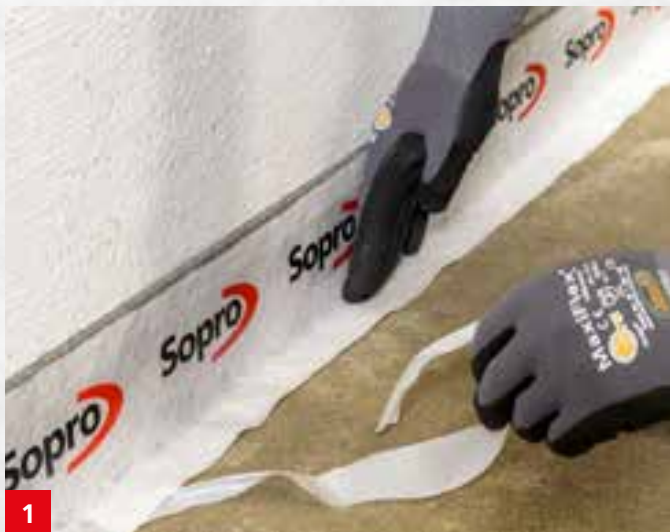
1 Stellen des Randdämmstreifens.
