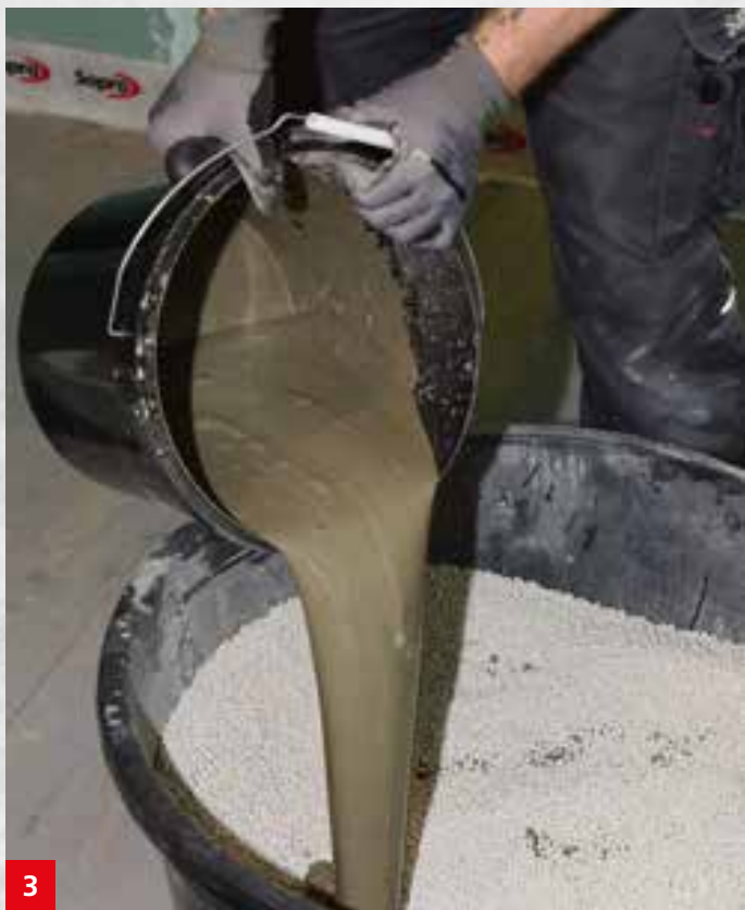
3 Sopro SMART® LZ LeichtZuschlag mit einer zuvor angemischten Schlämme aus Sopro SMART® BM BindeMittel und Wasser anmischen. Bei Verwendung eines Zwangsmischers analog vorgehen.
