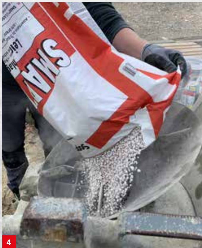
4 Bei größeren Flächen empfiehlt sich der Einsatz einer Estrichpumpe. Zunächst Sopro SMART® LZ LeichtZuschlag, dann Sopro Rapidur® B5 oder SoproTherm® SE-Z und anschließend die notwendige Wassermenge in die Estrichpumpe geben.
