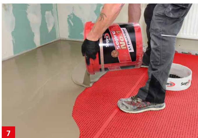
Anschließend erfolgt das Einbringen des Sopro VarioFließpachtels (min. 10 mm Schichtstärke im ausgehärteten Zustand). Das Ausgießen erfolgt eimerweise, aus niedriger Höhe und in Überlappungsrichtung der Bahnenstöße. Es muss immer nahezu direkt bzw. nur mit leichtem Überschuss auf Höhe eingegossen werden.
