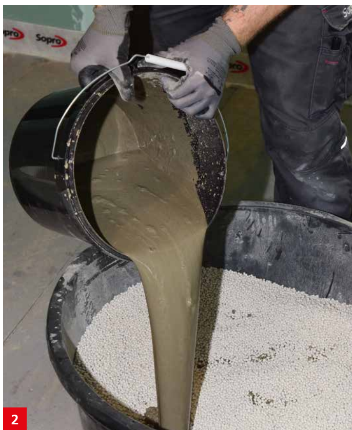
2 Sopro SMART® LZ LeichtZuschlag mit einer zuvor angemischten Schlämme aus Sopro SMART® BM BindeMittel und Wasser anmischen. Bei Verwendung eines Zwangsmischers analog vorgehen.
