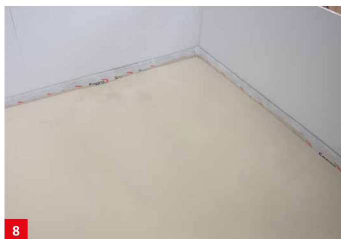
Nach ca. 3 Stunden ist die Fläche begehbar und belegereif für die Verlegung von Keramik.
