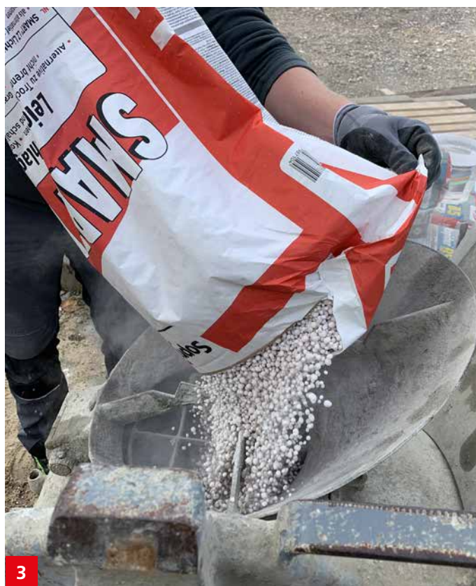
3 Bei größeren Flächen empfiehlt sich der Einsatz einer Estrichpumpe. Zunächst Sopro SMART® LZ LeichtZuschlag, dann Sopro Rapidur® B5 bzw. SoproTherm® SE-Z und anschließend die notwendige Wassermenge in die Estrichpumpe geben.
