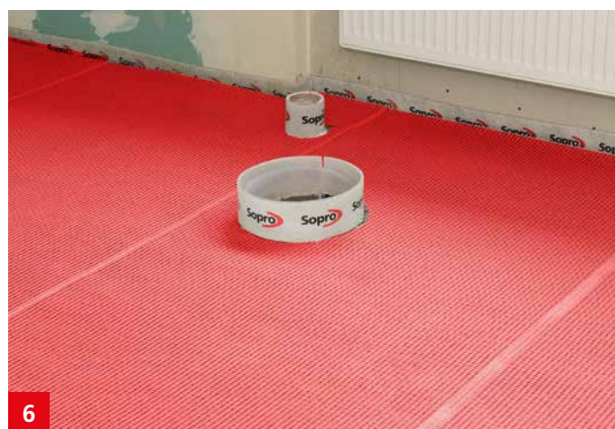
Nach ca. 12 Stunden kann das Sopro PanzerGewebe eXtra eingebracht werden. Die Bahnen müssen mit 5 cm Überlappung ausgelegt werden.
