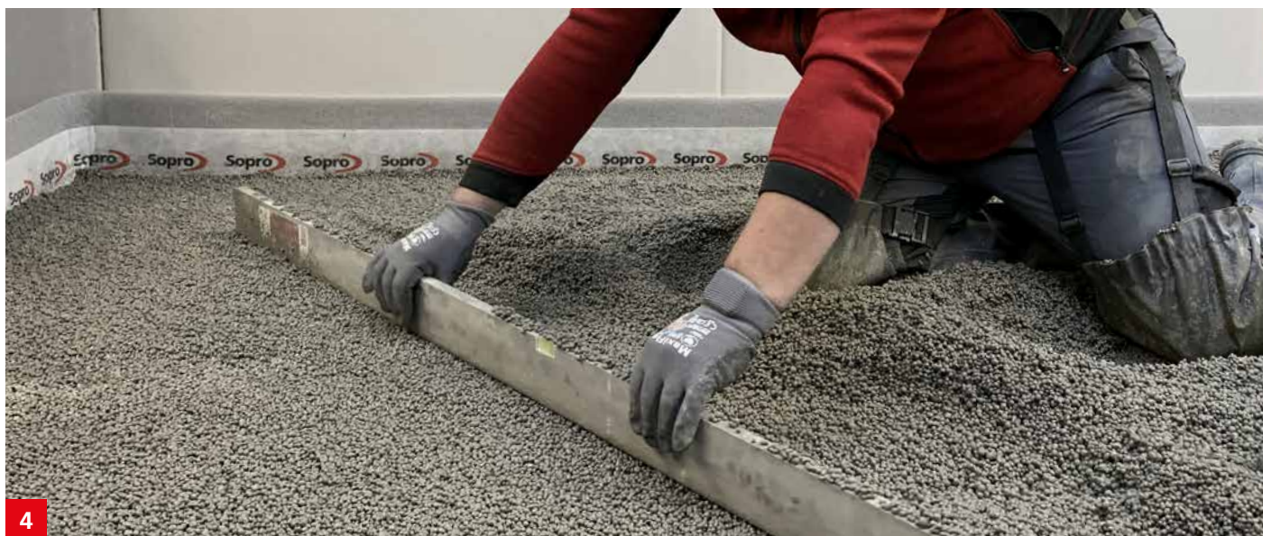
Das Einbringen des Sopro SMART® Leichtausgleichs erfolgt analog zu einem konventionellen Estrich.
