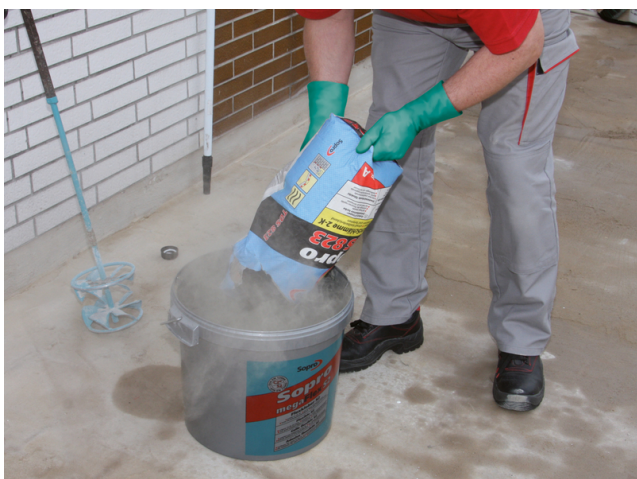
Hinzugeben der Trockenkomponente der Sopro TurboDichtSchlämme 2-K.
