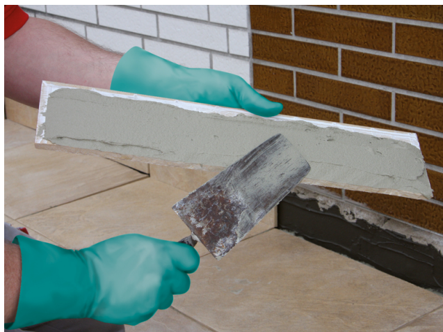
Auftragen eines Sopro Flexklebers (z. B. Sopro's No. 1, Sopro FKM® XL) auf die Rückseite der zurechtgeschnittenen Sockelfliese ...
