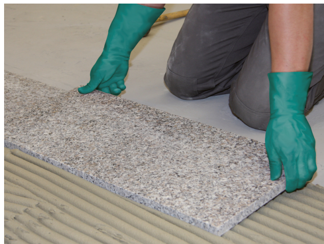
Natursteinplatte einlegen und ausrichten. Fugennetz vor der Erhärtung auskratzen.
