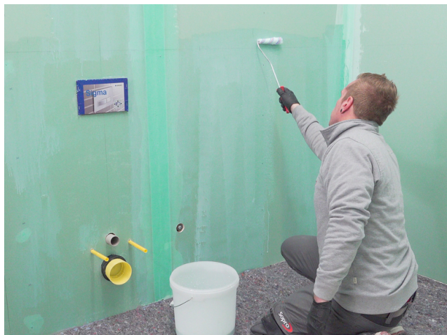
Saugende Untergründe mit Sopro Grundierung vorbehandeln.
