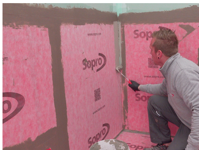
Stoßbereiche der Sopro AEB® Abdichtungs- und Entkopplungsbahn werden mit Sopro AEB® Dichtband Flex (mit Falz) überarbeitet.
