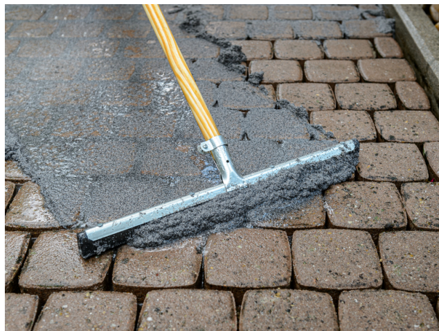
Sanierung einer Pflasterfläche mit Sopro Solitär® F20.
