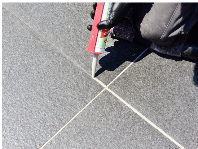
Anschluss- und Bewegungsfugen einbringen.
