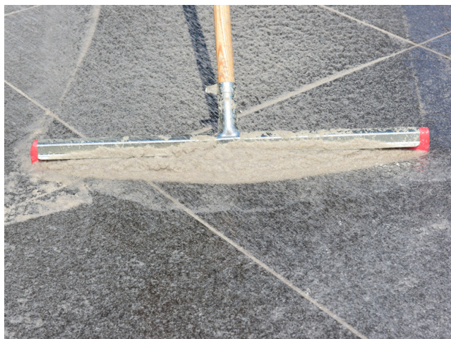
... und mittels Gummischieber in die Fuge einbringen.
