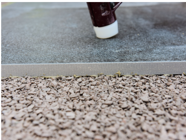
Die Platten einlegen und einklopfen.
