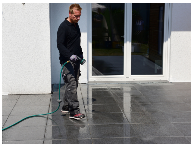
Vor der Verfugung muss die Fläche satt vorgesenst und feucht gehalten werden.
