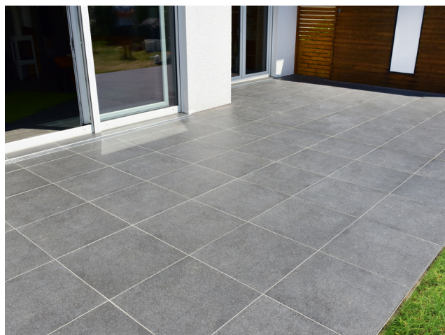
Die verfugte Oberfläche ist nach ca. 24 Stunden begehbar.
