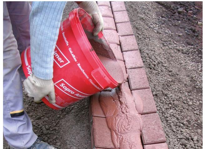
Ausgießen der farblich abgestimmten Sopro BetonSteinFuge.
