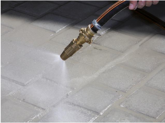
Absprühen mit feinem Wassersprühstrahl nach Erstarrungsbeginn des Fugenmörtels.
