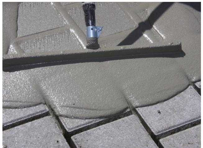
Fugenfüllendes Einbringen von Sopro BetonSteinFuge.
