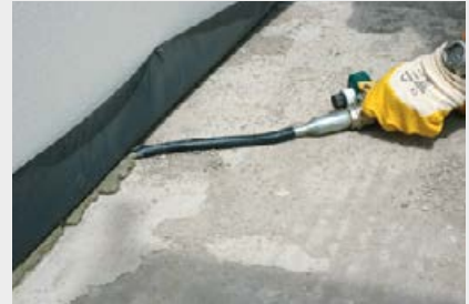
Maschinelles Verfüllen der Bauteilfuge
