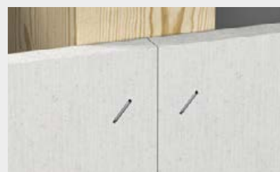
Platten stumpf gestoßen
