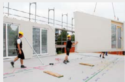
Montage auf der Baustelle
