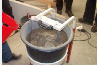
Anmischen fermacell™ Quellmörtel
