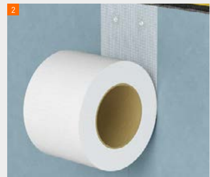
Aufbringen des fermacell™ Amierungsbandes HD
