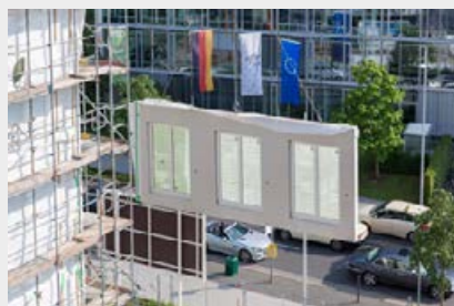
Krantransport auf der Baustelle
