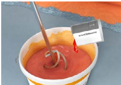
Abb. 7: 2. Auftrag: Farbkonzentrat zur Restmenge der Flüssigfolie geben und homogen einrühren. Eingefärbte Flüssigfolie satt auftragen. Weitere Informationen sind im Produktdatenblatt zu finden. Es ist empfehlenswert, den zweiten Anstrich quer zum Ersten aufzutragen, um evtl. Fehlstellen in der Abdichtungsschicht zu vermeiden.
