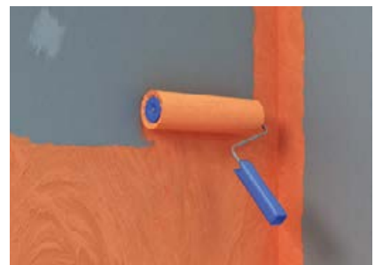
Abb. 6: Sicherstellung der Abdichtung für die Wasser- einwirkungs- klassen W1-I und W2-I. fermacell™ Flüssigfolie mit der Rolle mind. 2 x vollflächig auftragen (Trockenschichtdicke mindestens 0,5 mm). Gemäß DIN 18534-3 wird für den 2. Auftrag ein Farbunterschied zur besseren Nachvollziehbarkeit gefordert. 1. Auftrag: fermacell™ Flüssigfolie in Originalfarbe satt auftragen und trocknen lassen
