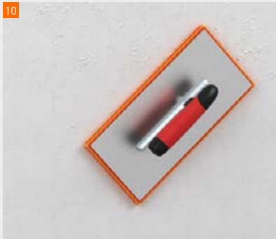
Abfilzen der Putzoberfläche mit einer Schwamm-scheibe
