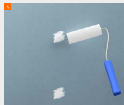
Deckendes Abtupfen der Verbindungsmittel in der Plattenfläche
