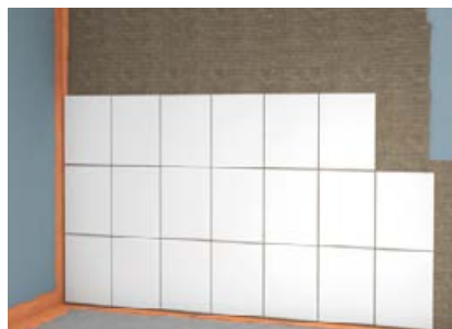
Abb. 5: Sicherstellung der Abdichtung für die Wasser- einwirkungs-klasse W0-I. Verfliesung mit fermacell™ Flexkleber im Dünnbettverfahren
