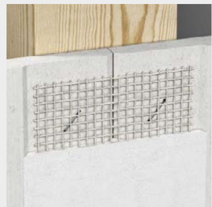
Trockenbaukante -Plattenstoß dicht gestoßen
