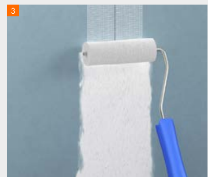
Aufrollen des fermacell™ Amierungsklebers HD
