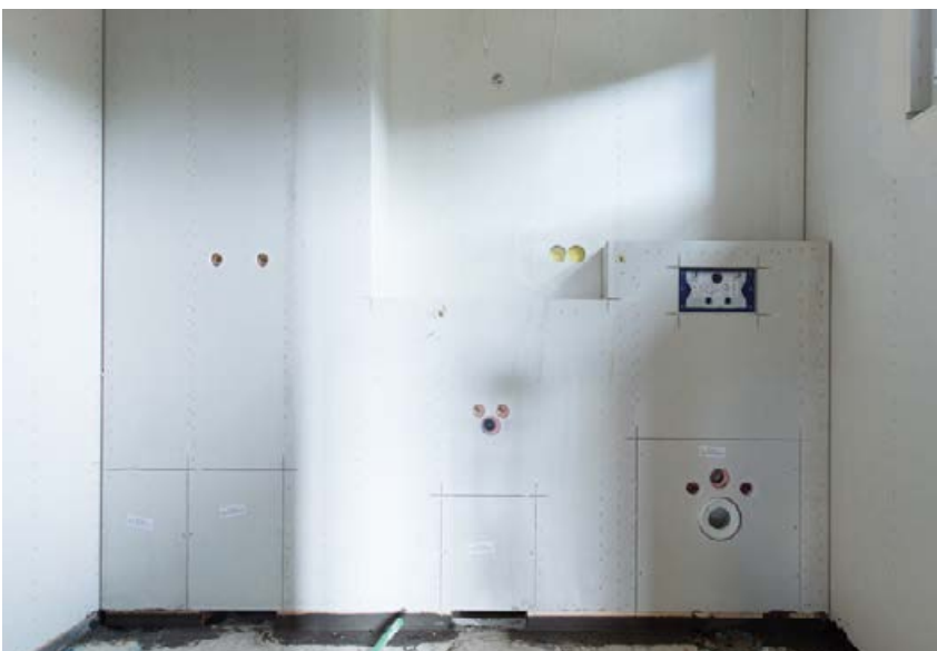
Tragständer für wandhängende WCs mit Einbauspülkästen
