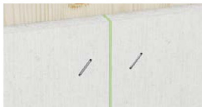
fermacell™ Klebefuge, Fugenbreite \leq 1 mm
