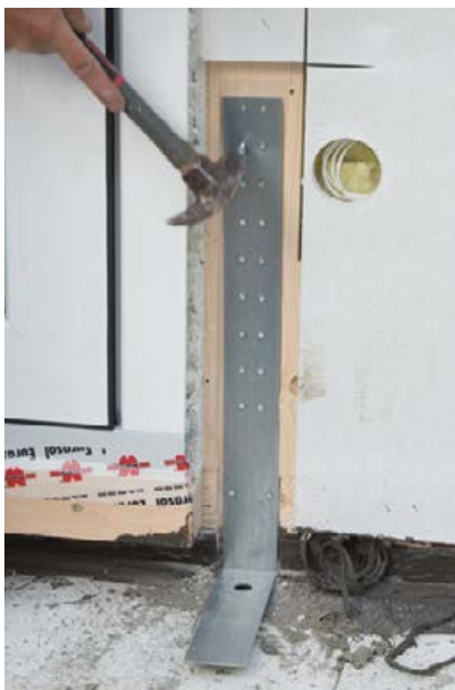
Montage Zuganker (Verdübelung Lastplatte noch nicht erfolgt)
