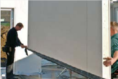
Positionieren, Ausrichten und Unterklotzen der Wandelemente
