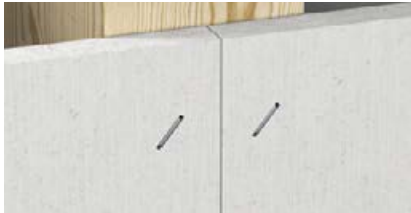
Plattenstoß dicht gestoßen, Fugenbreite \leq 1 mm
