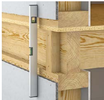
Bild 1: Ausrichten der Wandelemente
