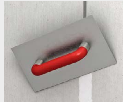
Spachteln von Fugen, entscheidend für Oberflächenqualitäten Q1 bis Q4
