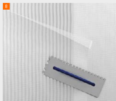
Überlappung des Armierungsgewebes mit ca. 100 mm
