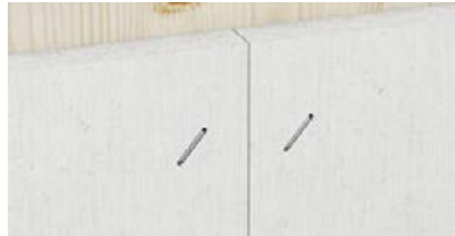
Plattenstoß dicht gestoßen, Fugenbreite \leq 1 mm
