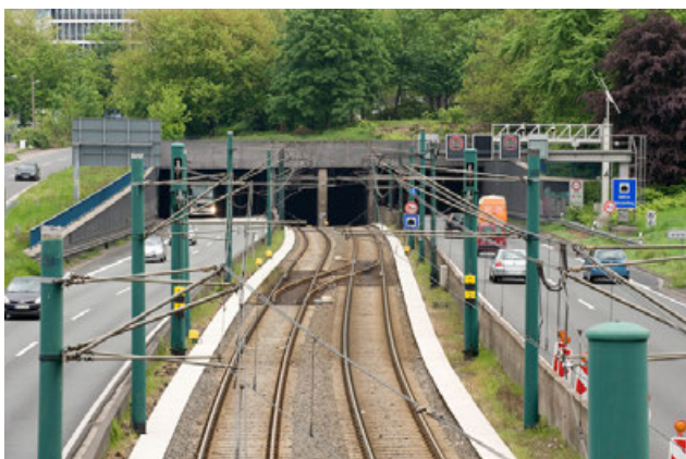
Ruhr Schnellweg Essen - Aestuver® D+2-Elemente als Flucht- und Rettungswege im Tunnelbereich
