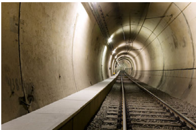
Ruhrbahn Essen – Holzplanken auf dem Fluchtweg durch die U-Bahn werden durch Aestuver® D+2-Elemente ersetzt
