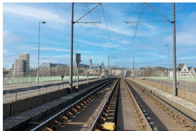
KVB Deutzer Brücke, Köln – Aestuver® D+2-Elemente als Kabelkanalabdeckung und Notlaufsteg
