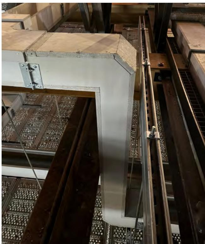
AESTUVER® Brandschutz-Kabelkanäle wurden in verschiedenen, werkseitig vorgefertigten Größen geliefert.
