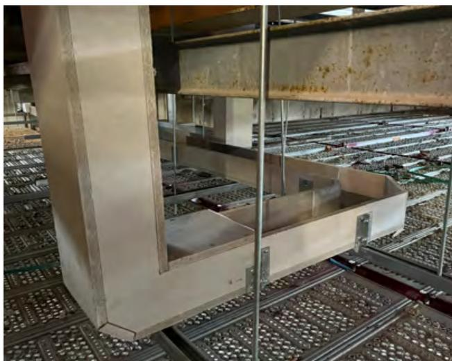
Nässeeinwirkung während der Einbauphase überstanden die Kabelkanäle schadlos.
