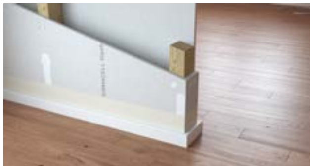
1 HT 11-391 fermacell™ Holzständerwand (Laibungsdetail/Klebefuge)
