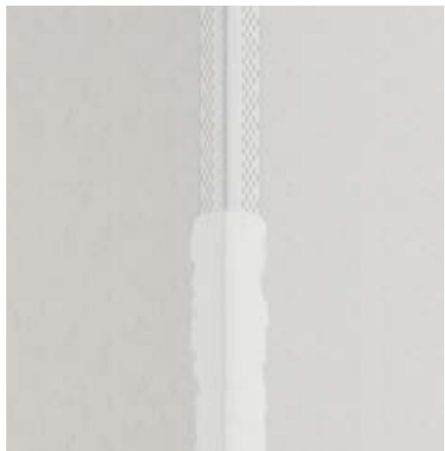
Luftdichte Abklebung einer Innenecke auf fermacell® Vapor
