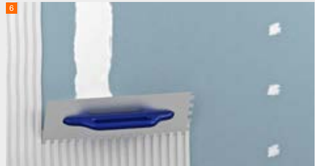
Aufbringen des fermacell™ Leichtmörtels HD mit 5–6 mm Schichtdicke für den Grundputz
