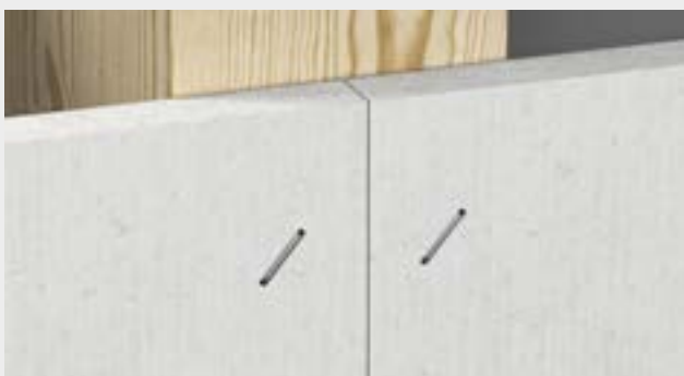
Plattenstoß dicht gestoßen -Fugenbreite ≤ 1 mm
