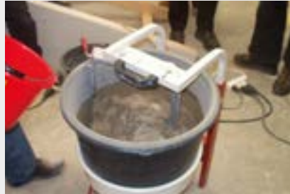
Anmischen fermacell™ Quellmörtel
