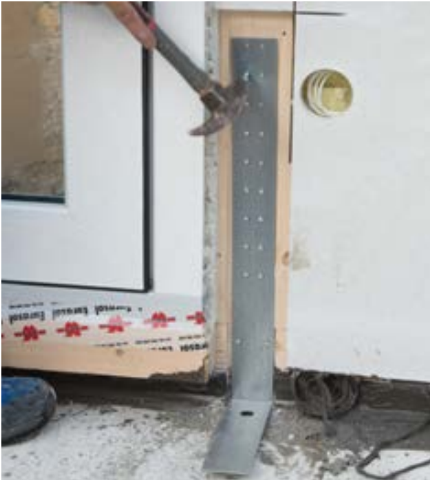
Montage Zuganker
