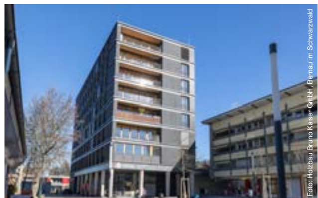
Gebäudeklasse 5 - Achtgeschossiger Holzbau - Wohn-/Gewerbebau Buggi 52
