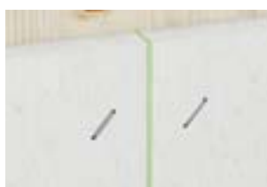
fermacell™ Klebefuge, Fugenbreite \leq 1 mm
