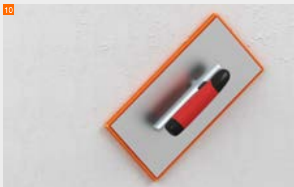
Abfilzen der Putzoberfläche mit einer Schwammscheibe
