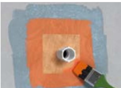
Abb. 4: Zur Abdichtung von Rohrdurchführungen die fermacell™ Wanddichtmanschette in die noch feuchte fermacell™ Flüssigfolie einbetten und direkt erneut überstreichen – Trocknungszeit mind. 1 Stunde
