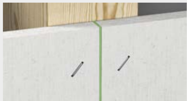
Klebefuge -Fugenbreite ≤ 1 mm
