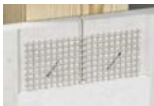
Trockenbaukante, Plattenstoß dicht gestoßen
