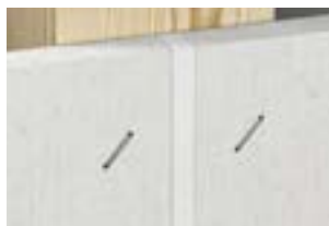
Fugenbreite in Abhängigkeit der Plattendicke (s.a. Seite 137)
