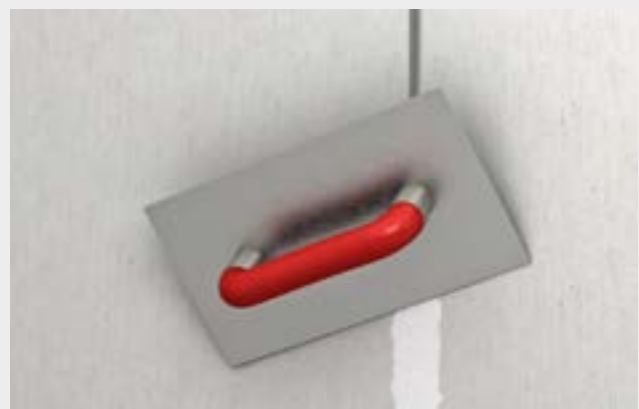
Spachteln von Fugen, entscheidend für Oberflächenqualitäten Q1 bis Q4
