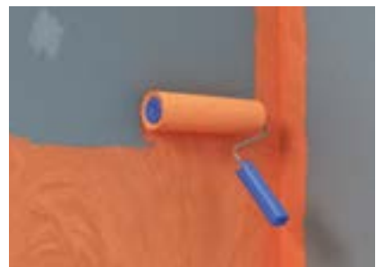
Abb. 6: Sicherstellung der Abdichtung für die Wassereintragsklassen W1-I und W2-I. fermacell™ Flüssigfolie mit der Rolle mind. 2 x vollflächig auftragen (Trockenschichtdicke mindestens 0,5 mm). Gemäß DIN 18534-3 wird für den 2. Auftrag ein Farbunterschied zur besseren Nachvollziehbarkeit gefordert. 1. Auftrag: fermacell™ Flüssigfolie in Originalfarbe satt auftragen und trocknen lassen
