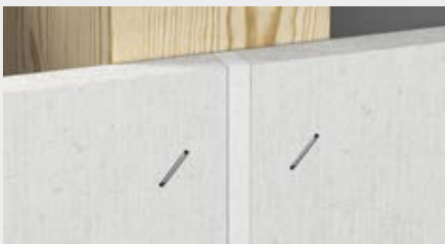
Spachtelfuge -Fugenbreite in Abhängigkeit der Plattendicke (s.a. Seite 137)
