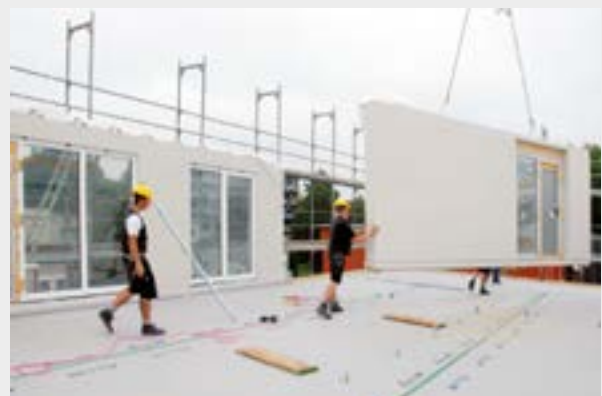
Montage auf der Baustelle
