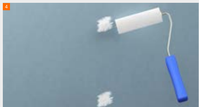
Deckendes Abtupfen der Verbindungsmittel in der Plattenfläche
