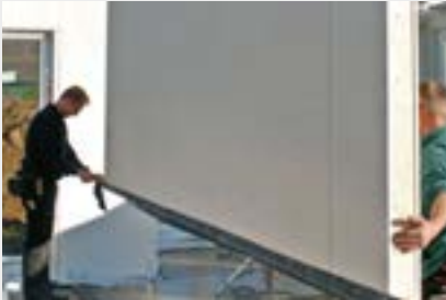
Positionieren, Ausrichten und Unterklotzen der Wandelemente
