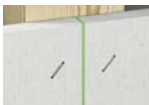
fermacell™ Klebefuge, Fugenbreite \leq 1 mm
