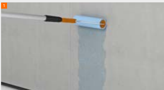
Grundierung mit fermacell™ Tiefengrund
