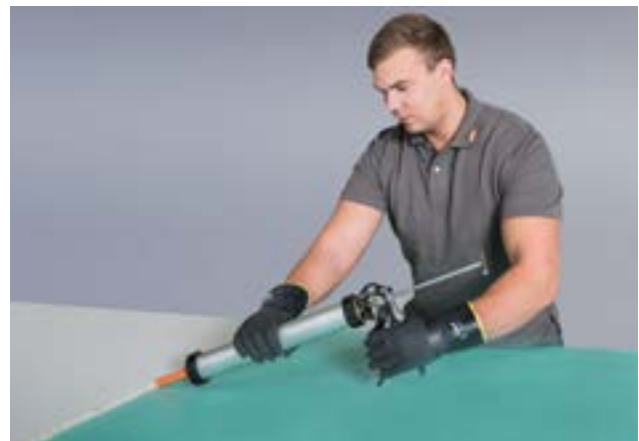
Aufbringen des fermacell™ Fugenklebers mit dem praktischen 580-ml-Folienbeutel
