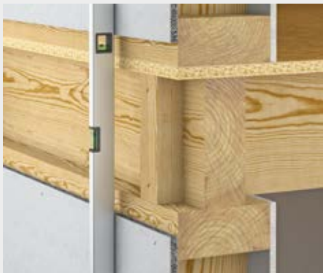
Bild 1: Ausrichten der Wandelemente
