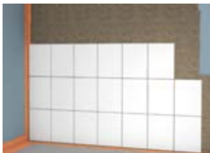
Abb. 5: Sicherstellung der Abdichtung für die Wassereintragsklasse W0-I. Verfliesung mit fermacell™ Flexkleber im Dünnbettverfahren
