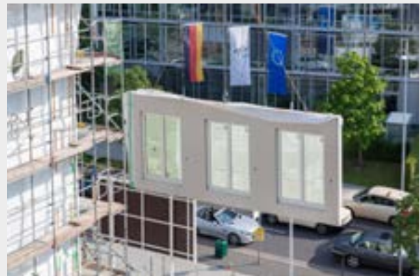
Krantransport auf der Baustelle
