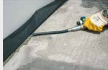
Maschinelles Verfüllen der Bauteilfuge
