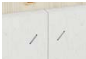
Plattenstoß dicht gestoßen, Fugenbreite \leq 1 mm
