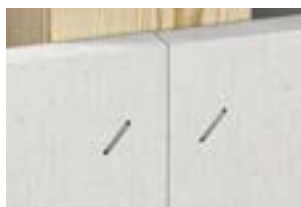
Plattenstoß dicht gestoßen, Fugenbreite \leq 1 mm
