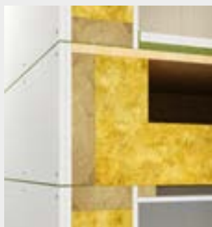
Abb. 5: Variante 4 – Deckenanschlussbereich
