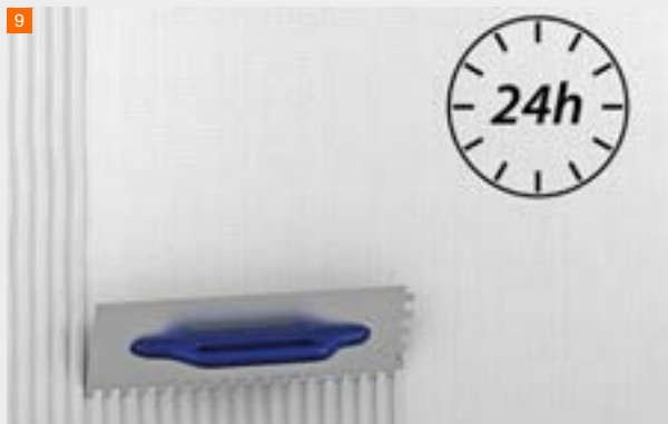
Aufbringen der zweiten Putzschicht 2–3 mm fermacell™ HD Leichtmörtel nach Erhärten der Armierungsschicht (Variante A)
