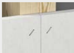
Platten stumpf gestoßen
