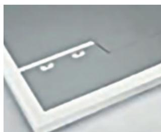
*Mechanisch befestigt im überdeckten Bahnenrand*
