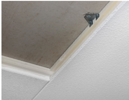
Kellerdeckendämmung unter Betondecke
