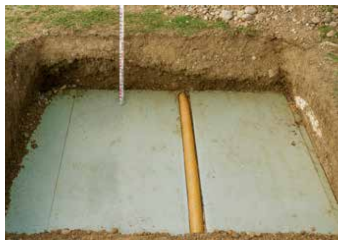
Abb. 5: Bild zeigt ein über 30 Jahre altes, begrüntes Umkehrdach
