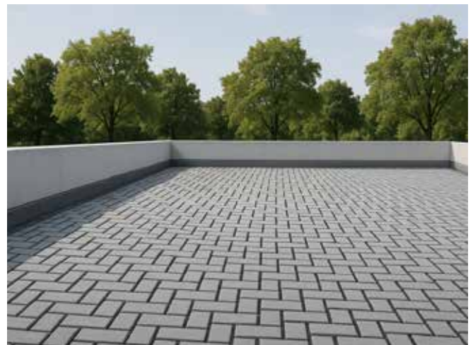
Abb. 42: Verlegtes Betonpflaster auf Styrodur®.
