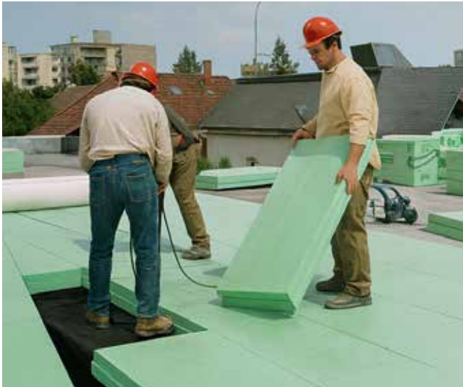
Abb. 10: Verlegung von Styrodur® beim Duodach.
