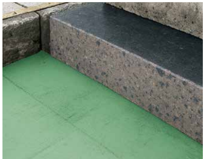
Abb. 45: Aufgeschnittene Ortbetonfahrbahnplatte zur wissenschaftlichen Untersuchung des Langzeitverhaltens.
