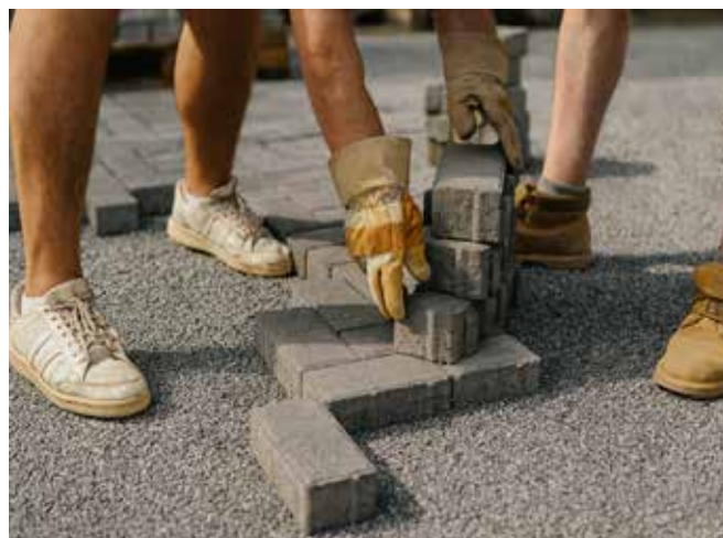
Abb. 41: Verbandverlegung eines Betonpflasters mit Grasfugen für einen Parkplatz auf einer Schulsporthalle.
