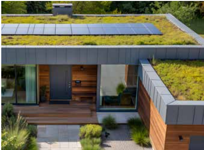
Abb. 25: Intensiv begrüntes Umkehrdach.
