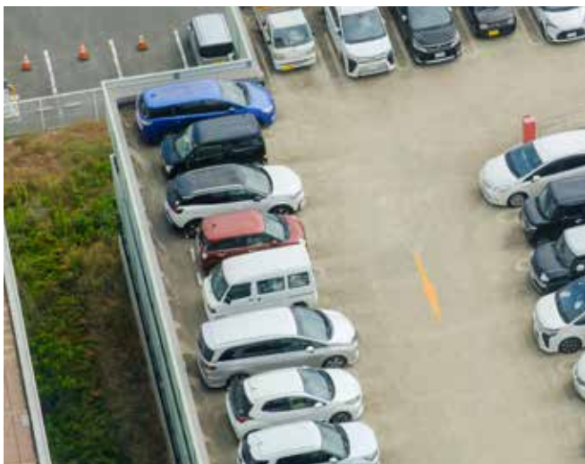
Abb. 44: Parkdach mit Ortbetonfahrbelag.
