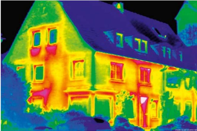
Übliche **konstruktionsbedingte Wärmebrücken** sind Querschnittsreduzierungen wie z.B. Fensterlaibungen, Heizkörpernischen, Rollladenkästen oder Installationsschlitze.
