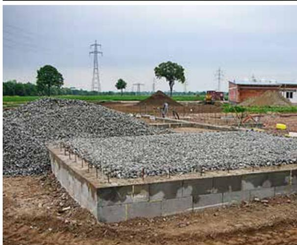
Bodenplatten mit **GEOMATERIALS Schaumglas** werden typischerweise ohne Streifenfundamente ausgeführt. Sollten die baulichen Anforderungen aber einmal Streifenfundamente erfordern (Hanglage, Niveauerhöhung), so ist **GEOMATERIALS Schaumglas** mit seinen Eigenschaften der optimale Baustoff zwischen den Fundamenten. Als Schüttmaterial ist **GEOMATERIALS Schaumglas** deutlich einfacher und schneller zu verarbeiten als Plattenware. Kein Zuschneiden, einfach schütten, verteilen und rütteln.
