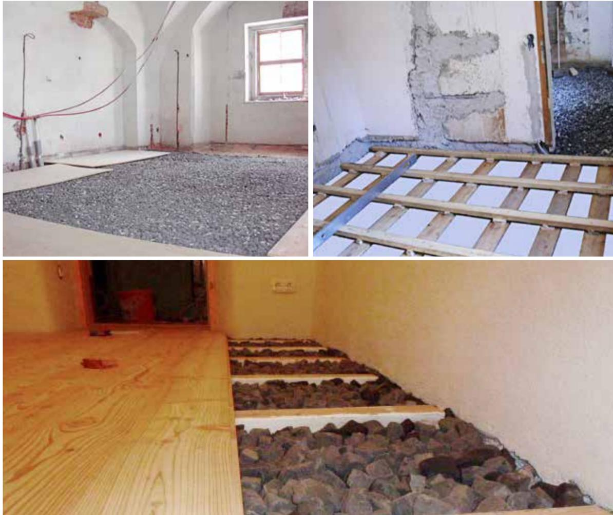
Der Fußbodenaufbau mit **GEOMATERIALS Schaumglas** eignet sich für Neubau und Sanierung. Besonders bei alten Gebäuden ist bei der Sanierung von Fußböden die verfügbare Aufbauhöhe begrenzt.
