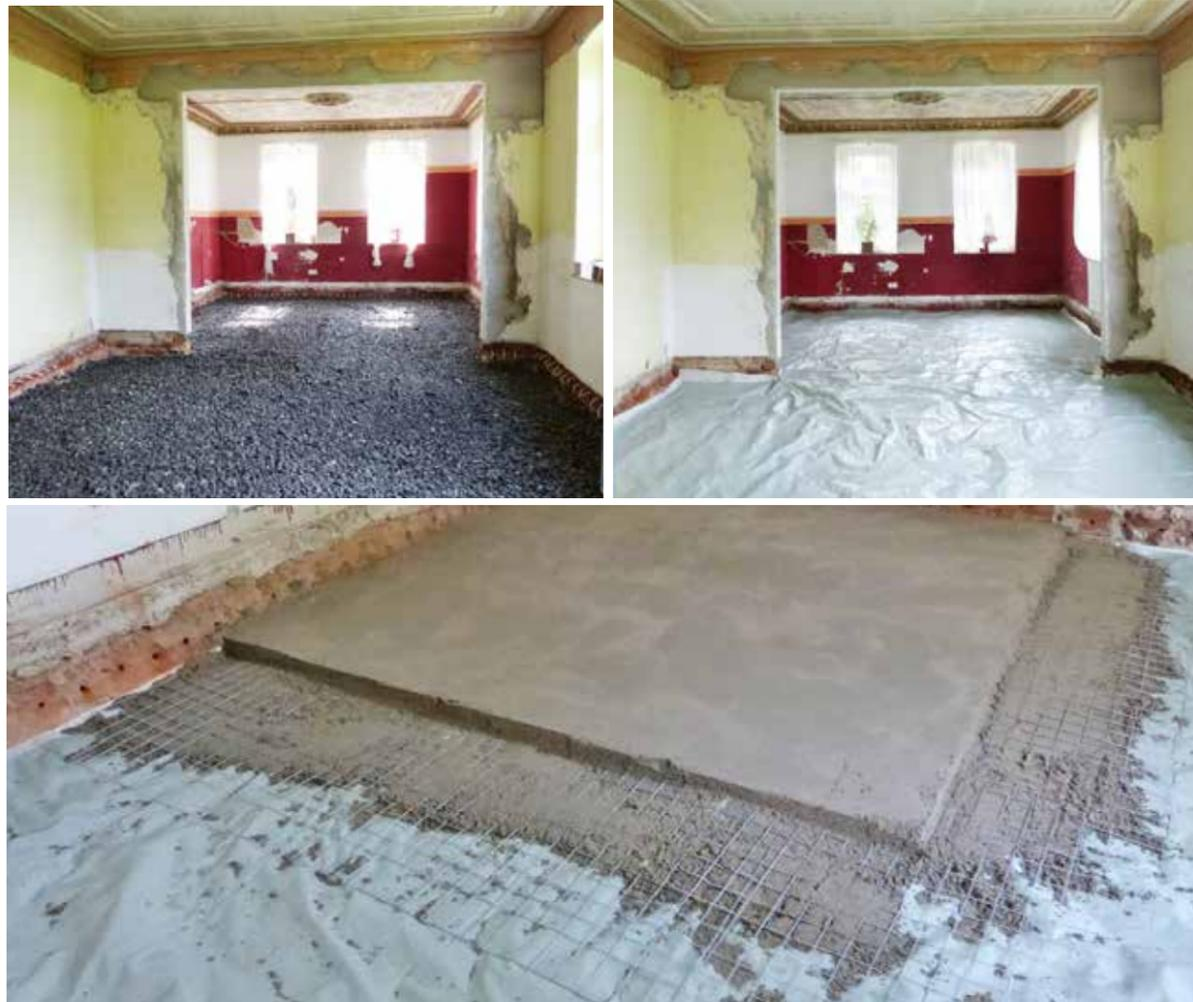
Mit **GEOMATERIALS Schaumglas** lässt sich eine deutlich geringere Aufbauhöhe realisieren. Durch den systematischen Aufbau mit z. B. 30 cm **GEOMATERIALS Schaumglas** im verdichteten Zustand erreichen Sie einen optimalen Fußbodenaufbau in Kombination mit einer nachfolgenden Estrichschicht.
