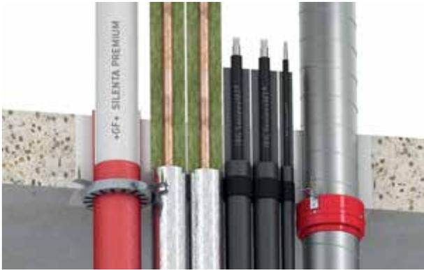
Die nach den Vorgaben des DIBt geforderten "größeren Abstände" können in der Praxis oftmals nicht umgesetzt werden. Veranlasst durch diesen Sachverhalt, wurden Abschottungen für nichtbrennbare und brennbare Rohre so geprüft, dass ein Abstand von 0 mm zwischen den einzelnen Abschottungen, sowie zwischen Abschottung und Bauteilaubung eingehalten werden kann.
