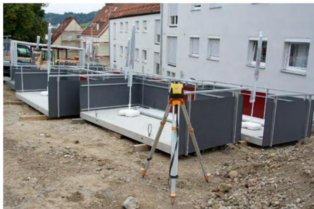
2. Versetzung des ersten Balkones im Erdgeschoss
