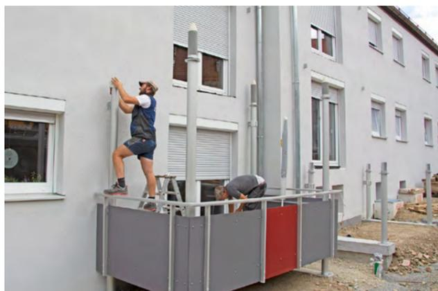
4. Balkon für das Obergeschoss wird auf die Stützen aufgefädelt.
