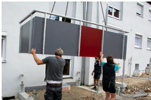
3. Aufstecken der Stützen; wandseitige Verschraubung mit Wandhaltern
