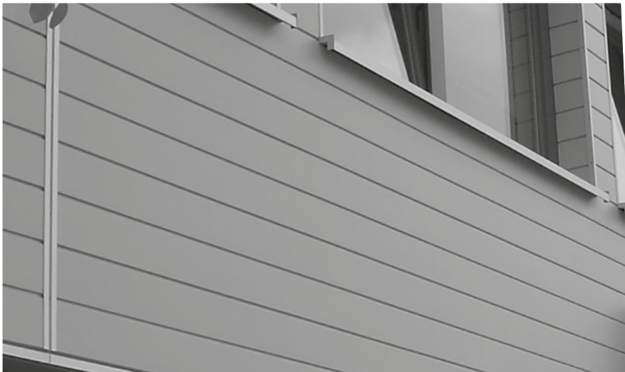
(A) Senkrecht durchlaufender Profilstoß
