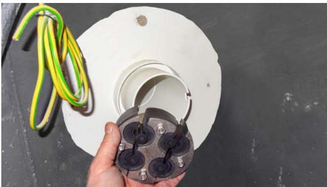
Montage einer Abschottung HSS mit druckdichter Kabelabdichtung
