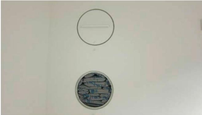
HVS Kabelschottung (Szenographie); oben: mit Verschlussdeckel
