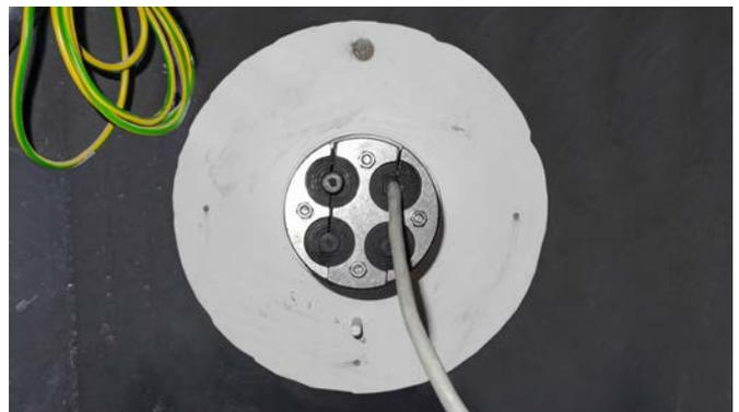
verlegtes Elektrokabel durch Kabelabschottung S90 System HSS
