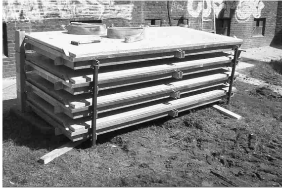
Vormontierte Balkonplatten auf verzinktem Stahlrahmen.
