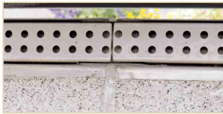
Edelstahlrinne ist durch eingeklebtes Verbindungselement verbunden.
