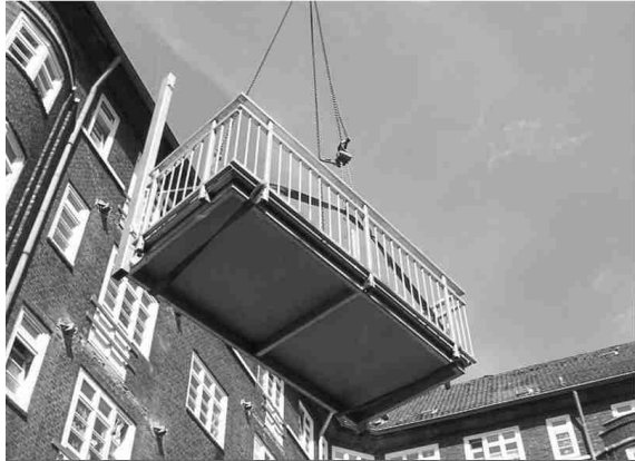
Das vormontierte Balkonelement wird mittels Kran transportiert.
